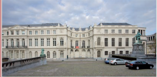
Vue de la façade du palais construit par Jean Foulx (1726-1766) auquel L.-B. Dewez succéda en 1766, place du Musée à Bruxelles (2012 © KIK-IRPA, Bruxelles)
