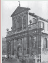
Vue de la façade principale (1914-1918 © KIK-IRPA, Bruxelles)
