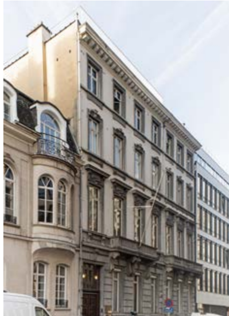
FIG. 5 Façade de la Fondation Universitaire, rue d'Egmont 9-11, 1945, arch. Maurice Haeck (A. de Ville de Goyet 2014 © urban.brussels).
