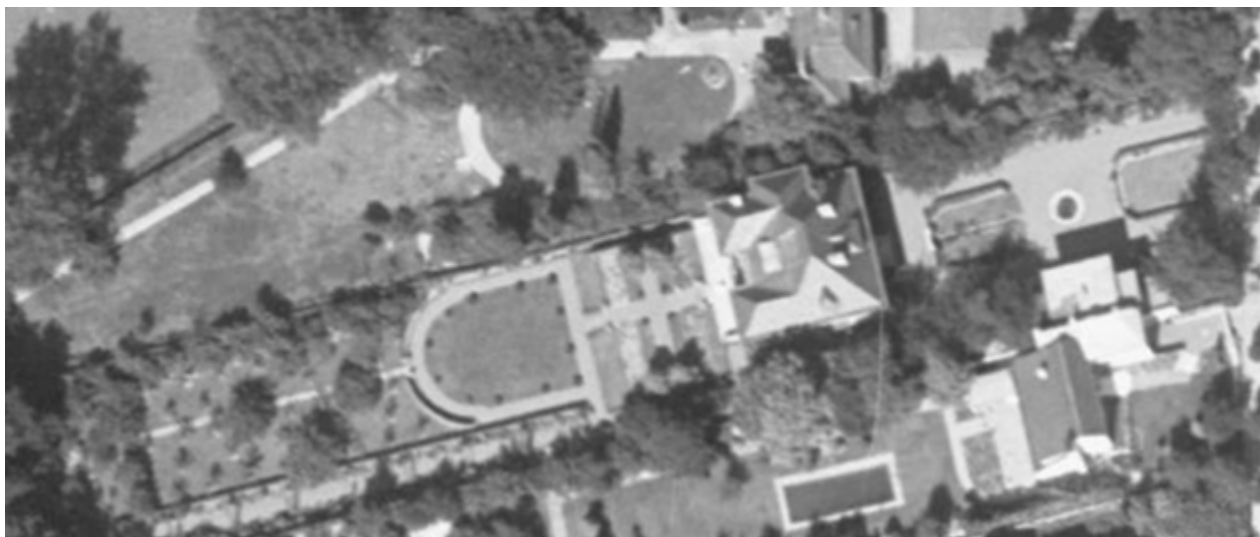
FIG. 17A Vue aérienne de la villa Van Keirsbilck et son jardin en 1953, ( https://bruciel.brussels ).
