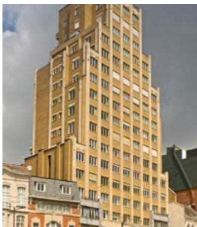
Résidence de la Cambre, 1938, arch. Marcel Peeters (© urban.brussels).
