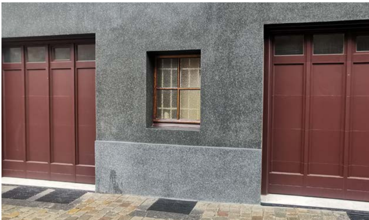
FIG. 6 Portes de garage, côté rue du Noyer, restituées à l'identique (M. Core, 2024 © urban.brussels).
