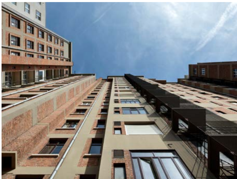
FIG. 4B Façade côté cour après restauration (© G. de Kinder, 2023).
