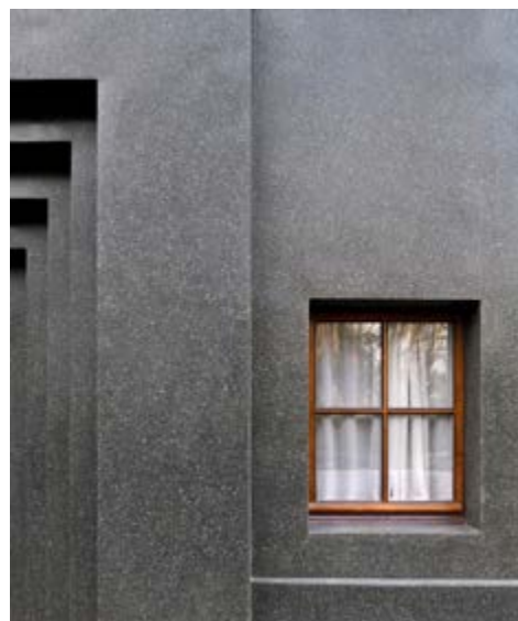
FIG. 3C Socle en granito et châssis après restauration (© G. de Kinder, 2024).
