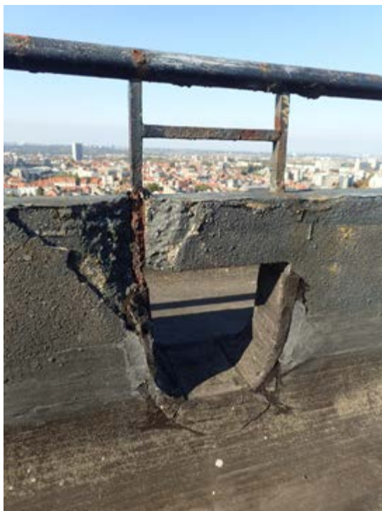
FIG. 5A Ancrage des mains courantes avant travaux (© Árter, 2020).
