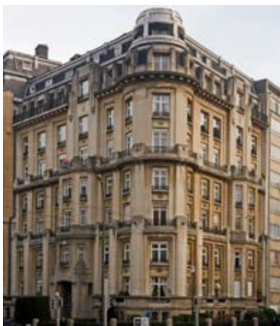
Palais de la Cambre, ensemble de 5 immeubles 1925-1930, arch. Camille Damman (© urban.brussels).
