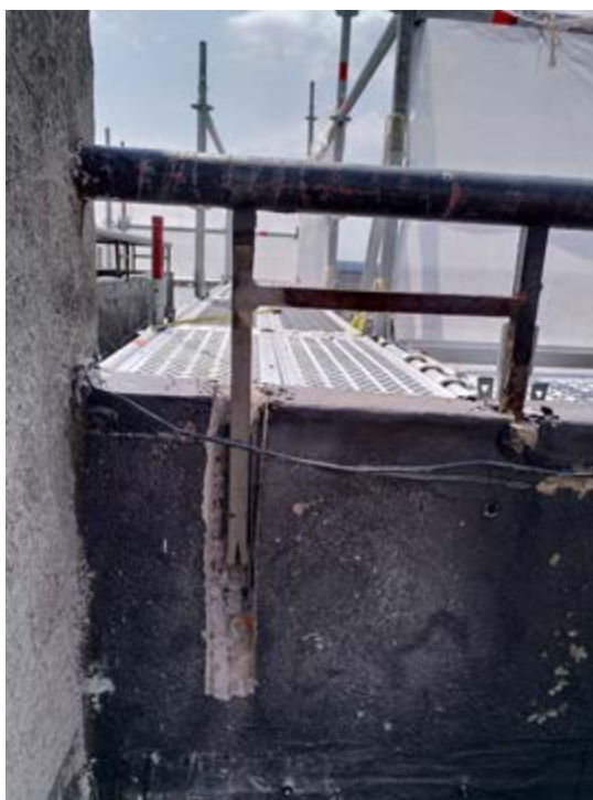
FIG. 5B Ancrages en cours de restauration (© Árter, 2021).
