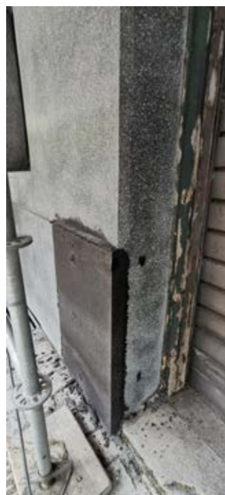
FIG. 3B Socle en granito poli, restitution à l'identique (M. Core © urban.brussels).
