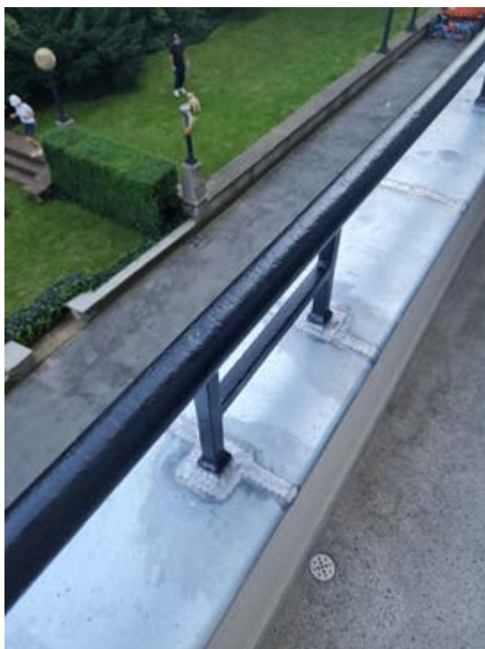
FIG. 5C Les mains courantes après restauration (© Árter, 2022).
