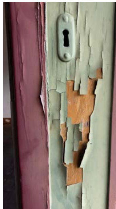
FIG. 6 Détail d'un châssis. La bichromie appliquée lors de la campagne de restauration 1988-1991 (© architectures parallèles).
