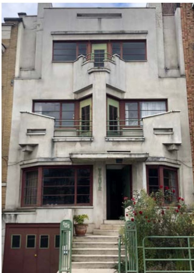
FIG. 2 La Withuis, avenue Charles Woeste 183, Jette, état en 2019, in Rapport photographique/demande permis d'urbanisme (© architectures parallèles).
