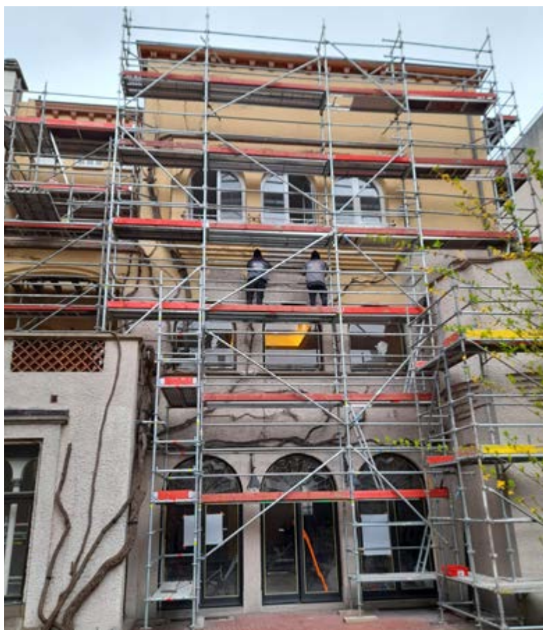
FIG. 4 La façade arrière, en cours de restauration. La structure de la vigne est protégée par une toile de jute (E. Demelenne, 2023 © urban.brussels).
