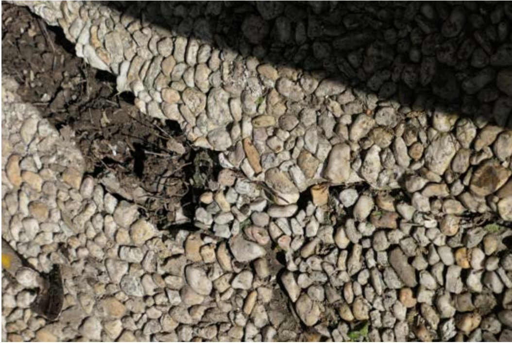
FIG. 12A Le jardin, détail des dégradations des chemins en galets. (E. Demelenne, 2020 © urban.brussels).
