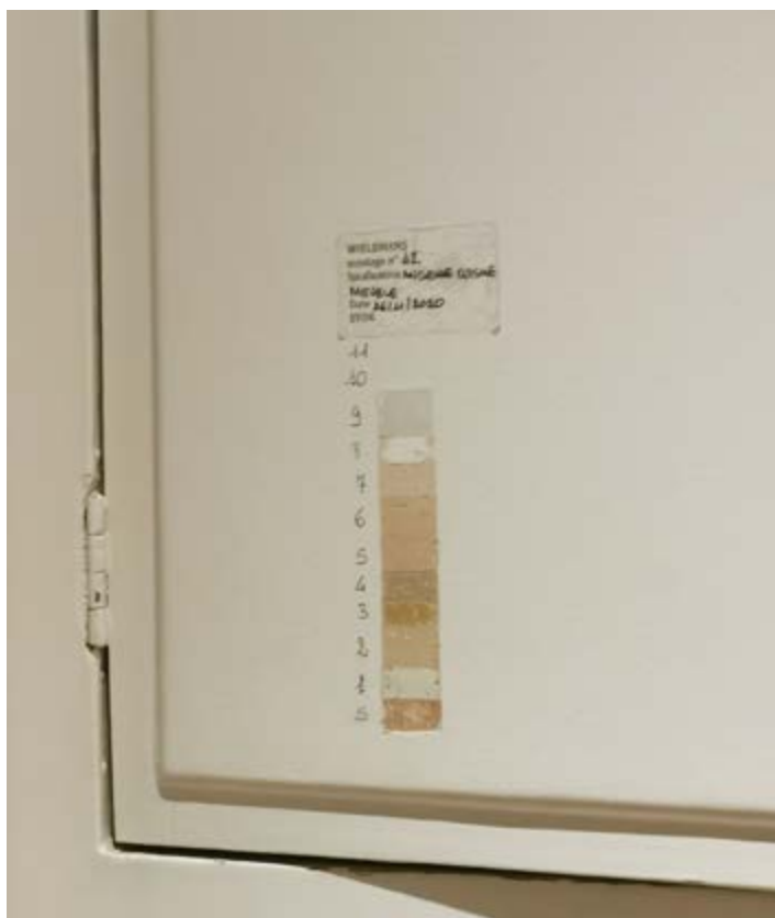
FIG. 5 Sondage stratigraphique, au-dessus de la cheminée du grand salon (C. Criquillon, 2020 © urban.brussels).
