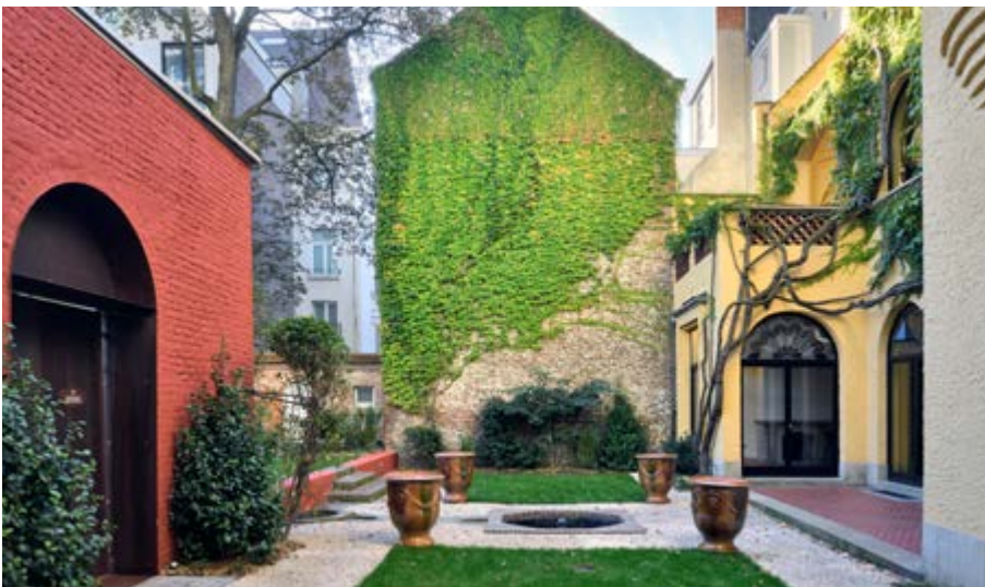
FIG. 15 Le jardin après restauration. La nouvelle connexion et les murs de fond enduits en rouge (picture © georgesdekinder.be).
