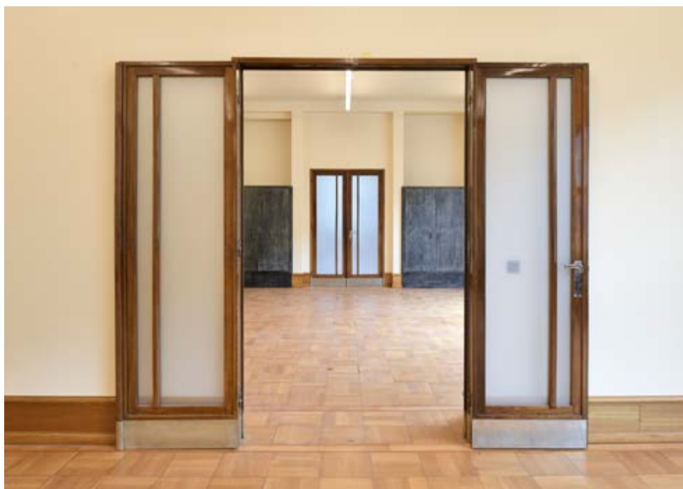
FIG. 8 Perspective caractéristique de l'hôtel communal de Forest, dans les espaces de bureaux : le regard peut traverser le bâtiment de bout en bout. Les menuiseries intérieures et les armoires en chêne cérusé intégrées dans les espaces de bureaux ont été restaurées sur base des études préliminaires (picture © georgesdekinder.be).
