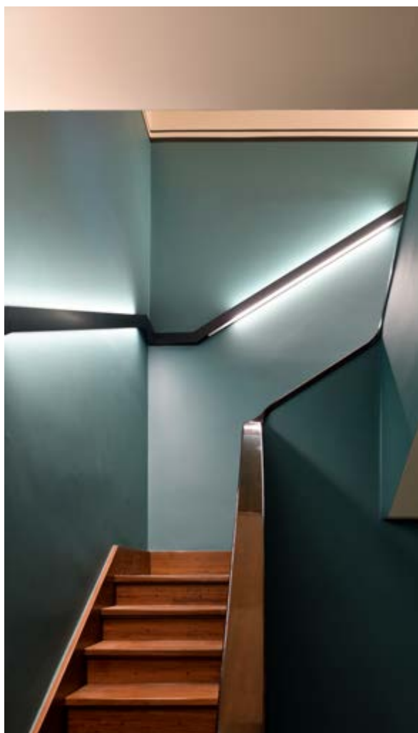
FIG. 11D Escalier en bois d'iroko, entièrement reverní, permettant un lien direct entre les bureaux des guichets et les locaux d'archives situés au sous-sol. La polychromie est celle d'origine, elle correspond à celle restituée dans les bureaux de la salle des guichets (picture © georgesdekinder.be).
