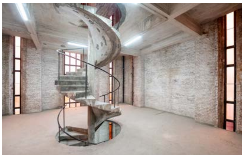
FIG. 11A Escalier hélicoïdal en béton situé dans la tour. Châssis métalliques munis de vitrages flammés de couleur rose/mauve (picture © pixelshake.be).
