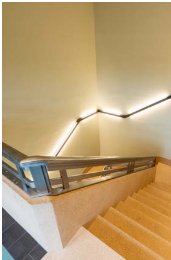
FIG. 11B Escalier en granito situé dans une aile arrière. Cet escalier menait des sous-sols au premier étage. Il a été prolongé pour permettre l'accès au deuxième étage (combles) désormais aménagé en bureaux. La partie prolongée de cet escalier se caractérise par une ferronnerie réalisée sur mesure, à partir des modèles d'origine (picture © pixelshake.be).
