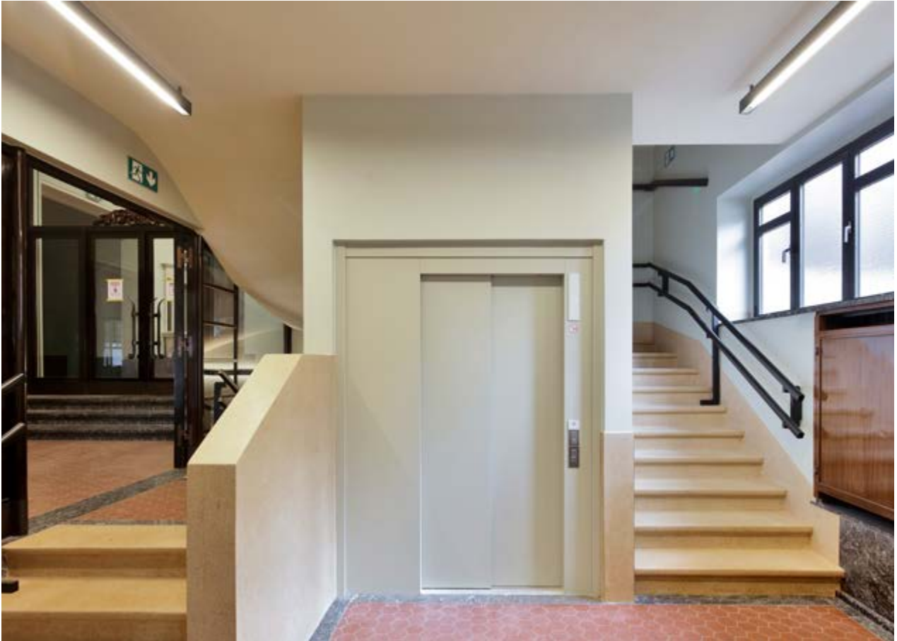
FIG. 3 L'escalier situé à l'entrée de la rue du Curé, a été partiellement démolli puis reconstruit afin de garantir l'accessibilité à tous les publics. Son traitement respecte l'esthétique de l'ouvrage original, notamment par l'usage du granito. La partie renouvelée se distingue par de nouvelles volées balancées, accompagnées de mains-courantes adaptées qui facilitent également le parcours des personnes à mobilité réduite (picture © georgesdekinder.be).
