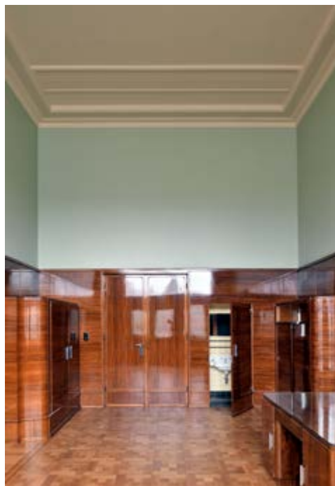
FIG. 6B Afin de leur rendre leur brillance, une couche de vernis, dont la composition a été étudiée et testée, a été appliquée sur les fins lambris. Cette opération a été menée sans les décaper pour éviter de les endommager (picture © georgesdekinder.be).
