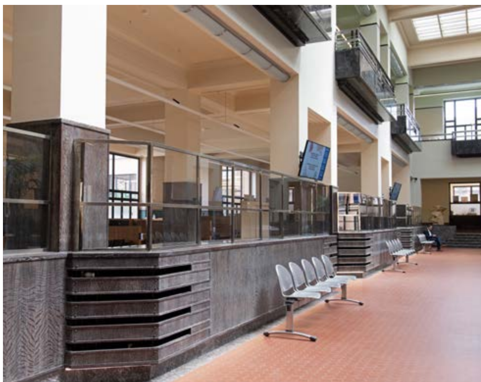
FIG. 9 Vue du mobilier d'origine intégré dans la salle des guichets. Les boiseries et menuiseries intérieures en bois de chêne présentaient un traitement cérusé, dont l'état était fort dégradé. L'aspect cérusé a été restitué (non plus au moyen de produits à base de plomb mais à base de produits acryliques) et complété par un vernis acrylique brillant en dialogue avec les revêtements en marbre noir et blanc ou gris (A. de Ville de Goyet, 2025 © urban. brussels).
