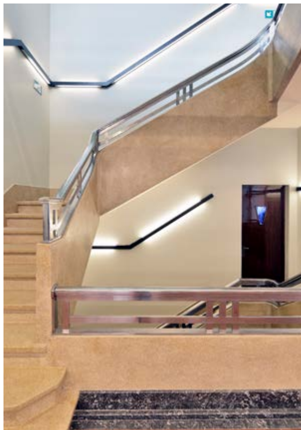
FIG. 11C Escalier en granito situé dans une aile arrière. Troisième de la « série », à associer à l'escalier « PMR » et à l'escalier « prolongé ». Cet escalier a été entièrement restauré. Le traitement de l'éclairage par un rail lumineux souligne le design de l'escalier (picture © georgesdekinder.be).
