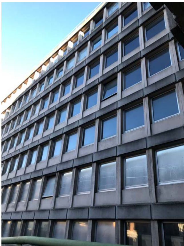
FIG. 4 Façade en béton architectonique (© Dorothée Stiernon).
