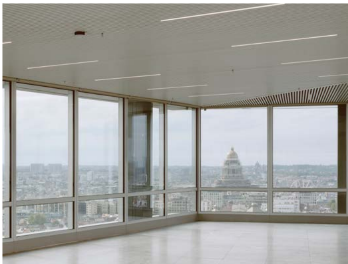
FIG. 3 The Louise, les châssis ont conservé leurs traverses, 2023 (J. Piret © A2RC).
