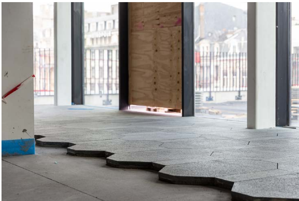
FIG. 4 Multi, récupération des dalles de sol (Courtesy of CONIX RDBM Architects © Jasper Van der Linden).
