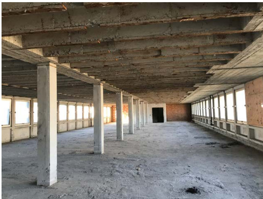
FIG. 3 Squelette en béton armé et plan ouvert (© Dorothée Stiernon).
