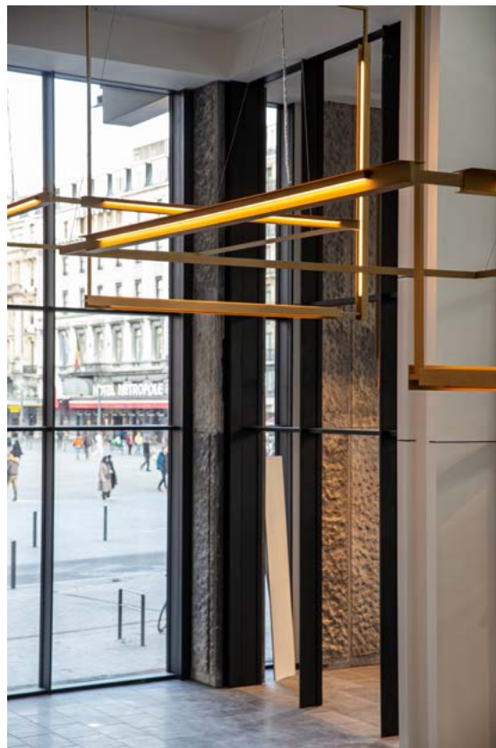
FIG. 5 Multi, recyclage des profils de châssis en armatures d'éclairage (© Courtesy of CONIX RDBM Architects).
