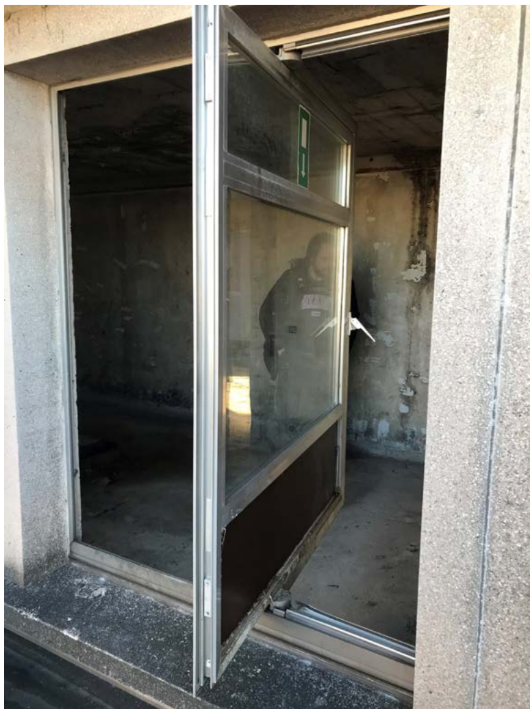
FIG. 5 Etat de conservation relativement bon de la peau extérieure et ses éléments (© Dorothée Stiennon).
