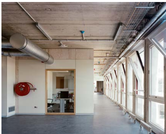
FIG. 3 ESP Karreveld, intérieur avec conduites et éléments structurels visibles, de nouvelles cloisons réalisées de matériaux de récupération et de panneaux multiplex (© Séverin Malaud).
