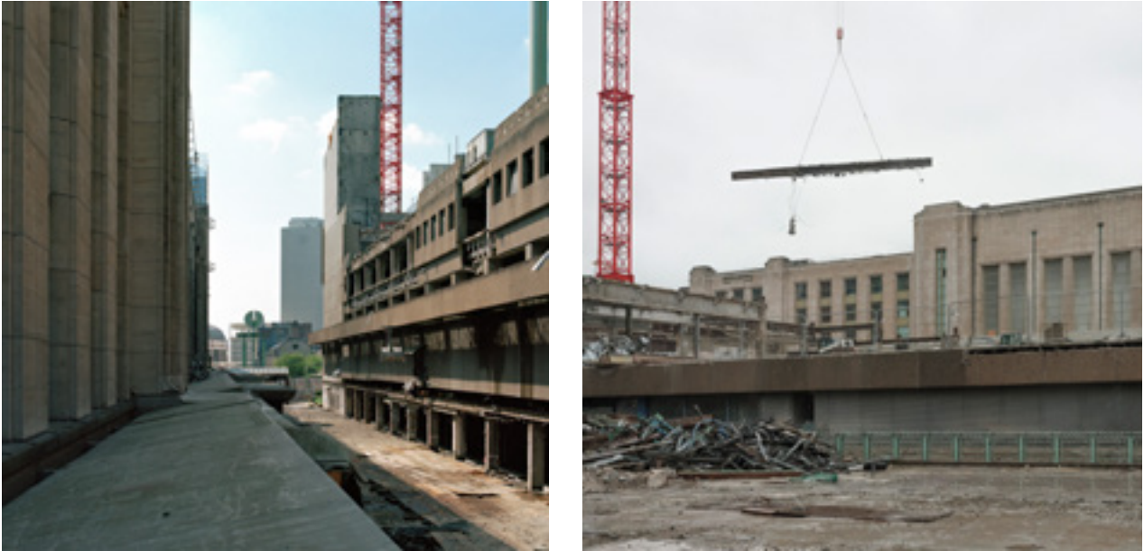
FIG. 1A, 1B Après la démolition du Communication Center North (CCN) en 2023-24, la reconstruction de la façade ouest de la gare du Nord est planifiée (© Adam Paluch, 2024).
