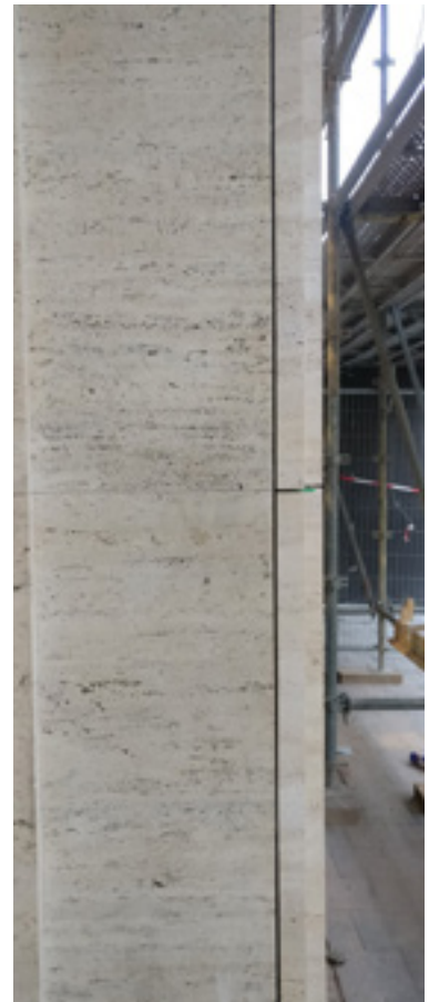
FIG. 2D Le système d'accrochage des nouvelles plaques en travertin est adapté aux normes contemporaines de sécurité (P.-Y. Lamy, 2022 © urban.brussels).
