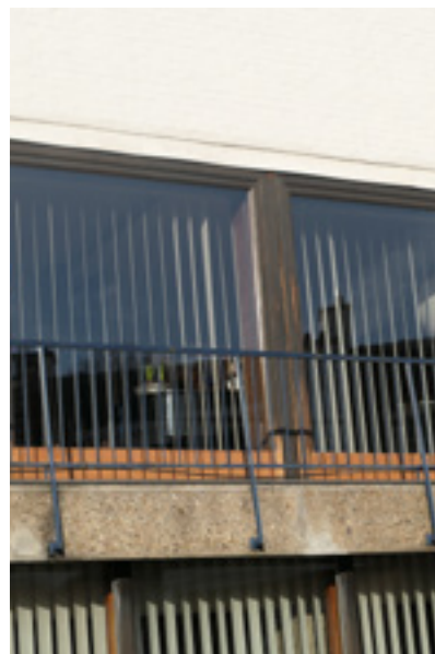
FIG. 4A, 4B Maison Volckrick à Watermael-Boitsfort, arch. Georges Volckrick 1958. Remplacement subtil de la menuiserie en teak et enlèvement de la finition noire non d'origine (P. Bernard, 2024 © urban.brussels).
