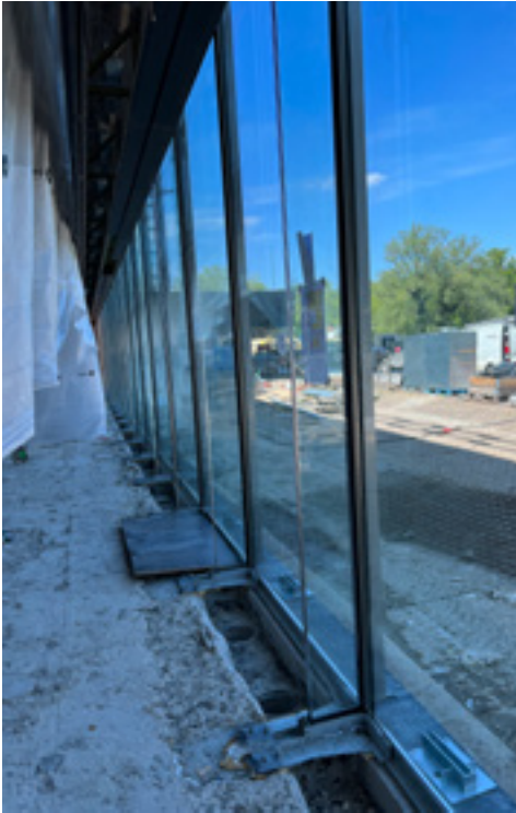
FIG. 6E Les grandes parois vitrées du socle sont remplacées par des vitrages plus performants mais également plus lourds, dont la stabilité est assurée par des feuilles de verre verticales transversales (© Alison Inglis, 2022).
