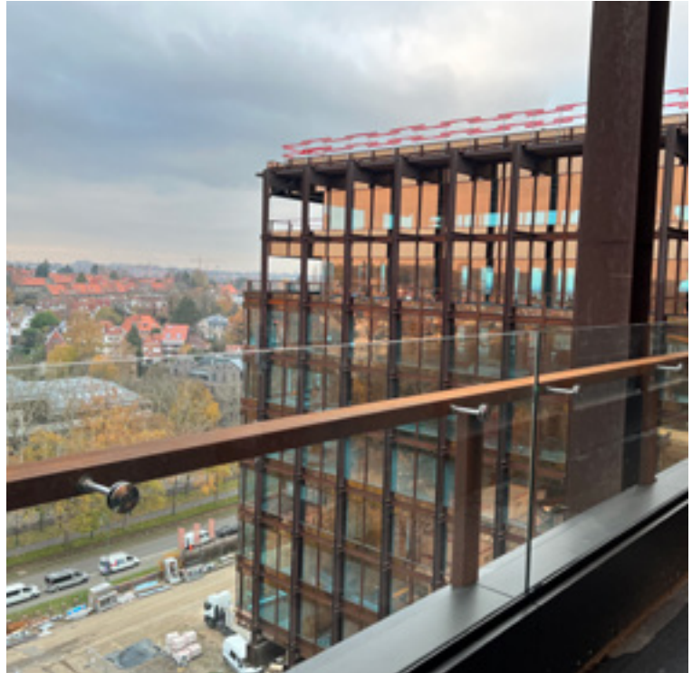
FIG. 6F Les garde-corps sont rehaussés afin de répondre aux normes contemporaines de sécurité (J.-M. Basyn, 2022 © urban.brussels).
