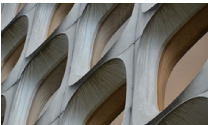
FIG. 8C Les façades avant leur entretien (J.-M. Basyn, 2018 © urban.brussels).
