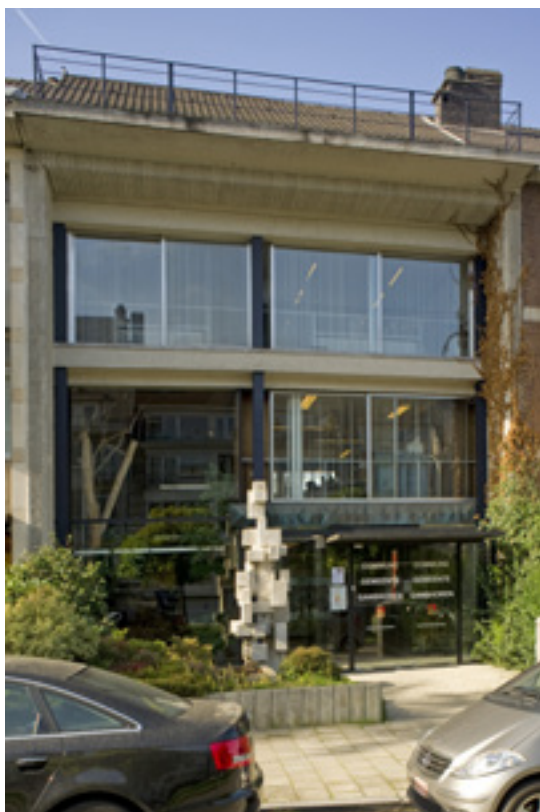
FIG. 37 Bureaux des architectes Raoul J. Brunswyck et Odon Whatelet, avenue de Villegas n° 31 à Ganshoren, 1965 (A. de Ville de Goyet, 2012 © urban.brussels).
