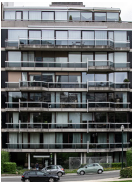
FIG. 43 Résidence Val du Roi, rue de Belle-Vue n° 2 et avenue du Général de Gaulle n° 52 à Ixelles. Lucien Jacques Baucher, 1964-1967, architecte paysagiste Jean Delogne, designer Christophe Gevers, sculpture métallique de Victor Vasarely (A. de Ville de Goyet, 2024 © urban.brussels).
