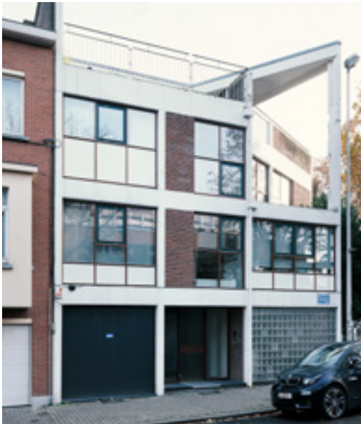
FIG. 20 Maison Verhaegen, rue Père de Deken n° 38 à Etterbeek. Willy Van Der Meeren et Léon Palm, 1960 (A. de Ville de Goyet, 2021 © urban.brussels).
