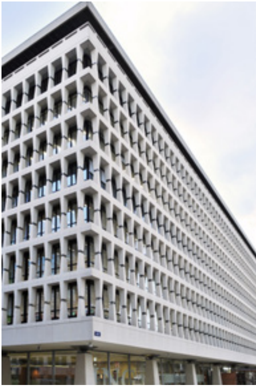
FIG. 28 Siège social d'ING (anciennement BBL), avenue Marnix n° 24 à Bruxelles. Gordon Bunshaft (SOM), 1960 (M. Vanhulst, 2012 © urban.brussels).
