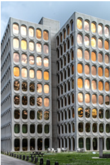
FIG. 26 Ancien siège social des Cimenteries Belges Réunies ou CBR, chaussée de La Hulpe n° 185 à Watermael- Boitsfort. Constantin Brodski et Marcel Lambrichs, 1970 (A. de Ville de Goyet, 2024 © urban.brussels).
