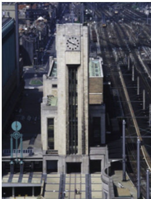
FIG. 2 Gare du Nord, rue du Progrès n° 80 à Schaerbeek. Paul et Jacques Saintenoy et Jean Hendrickx-Van den Bosch, 1938-1956 (Ch. Bastin et J. Evrard © urban.brussels).
