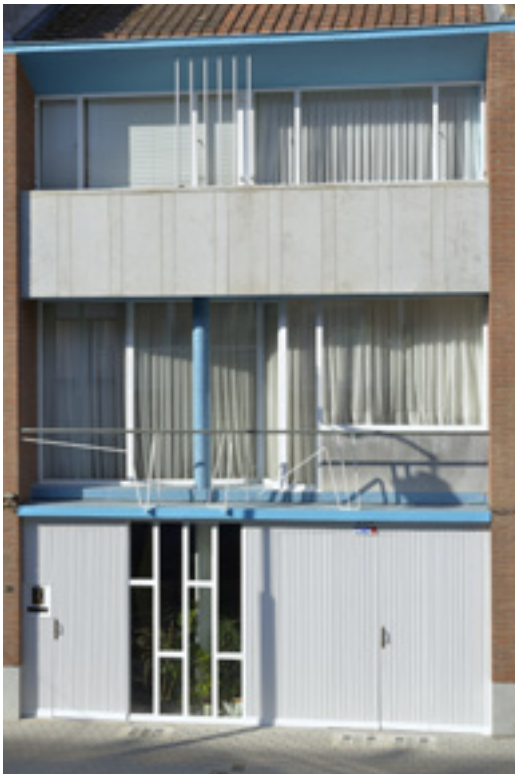
FIG. 22 Maison Durieu, rue de la Fraîcheur n° 26 à Molenbeek-Saint-Jean. Simone Guillissen-Hoa et Jacques Dupuis, 1954 (Nicolas Schimp, 2020 © urban.brussels).
