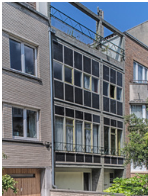
FIG. 18 Maison Moureau, avenue Adrien Bayet n° 11 à Molenbeek- Saint-Jean. Willy Van Der Meeren, 1951 (A. de Ville de Goyet, 2024 © urban.brussels).
