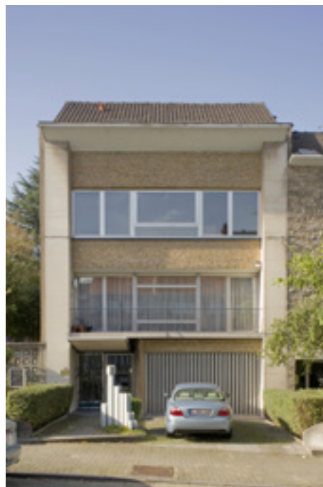
FIG. 36 Maison et bureau d'architecte de Raoul J. Brunswyck, avenue de Villegas n° 25 à Ganshoren, 1957 (A. de Ville de Goyet, 2012 © urban.brussels)
