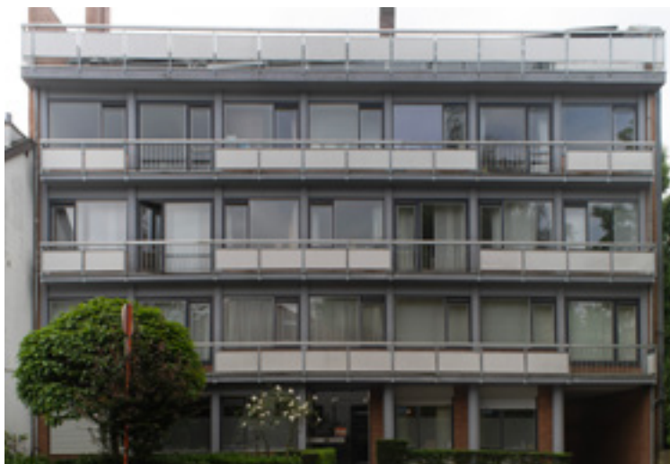
FIG. 41 Bureau et appartement de l'architecte Simone Guillissen-Hoa, rue Langeveld n° 21 à Uccle (A. de Ville de Goyet, 2024 © urban.brussels).
