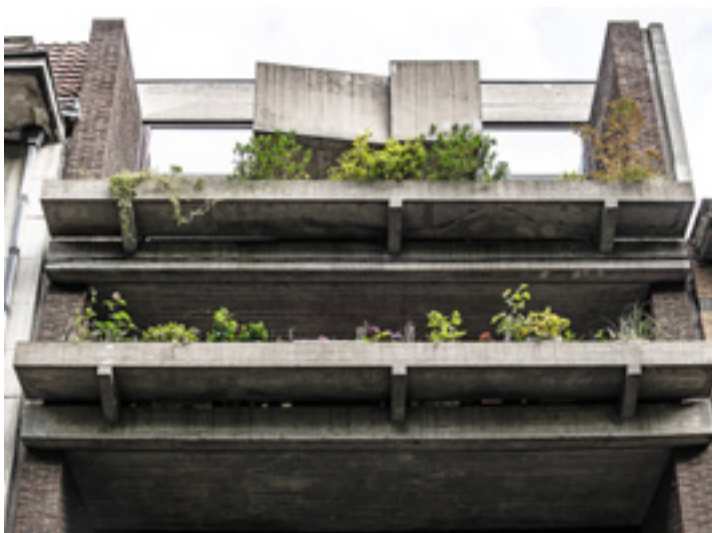
FIG. 40 Bureau et appartement de l'architecte Paul Caulier, avenue des Gloires Nationales n° 10 à Koekelberg, 1966 (A. de Ville de Goyet, 2024 © urban.brussels).
