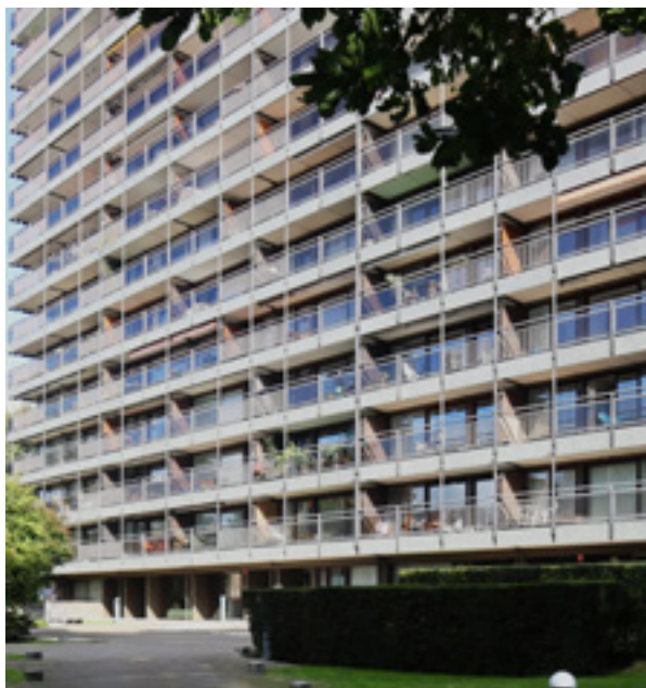
FIG. 7 Résidence Epsom rue au Bois n° 370-372 à Woluwe-Saint-Pierre. L'aspect est luxueux, rationaliste et fonctionnel grâce à la symbiose entre le béton architectural et l'exosquelette en fer (T. Verhofstadt, 2024 © urban.brussels).
