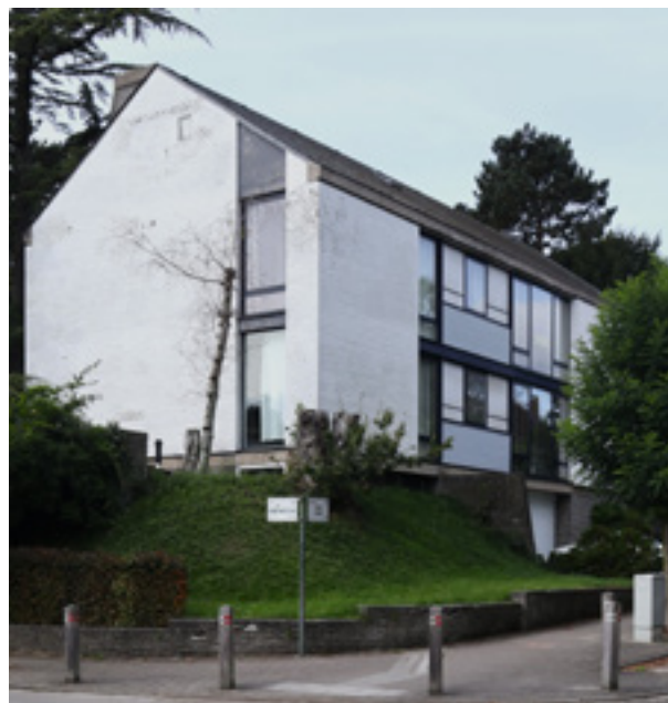
FIG. 8 Avenue des Héros n° 55 et 57 à Auderghem, arch. Pierre Meeus, 1959. La maison double comme une seule unité. L'architecte vivait au n° 55 de l'ensemble et avait son atelier au rez-de-chaussée. Le n° 57 était probablement habité par son père Fernand Meeus (T. Verhofstadt, 2024 © urban.brussels).
