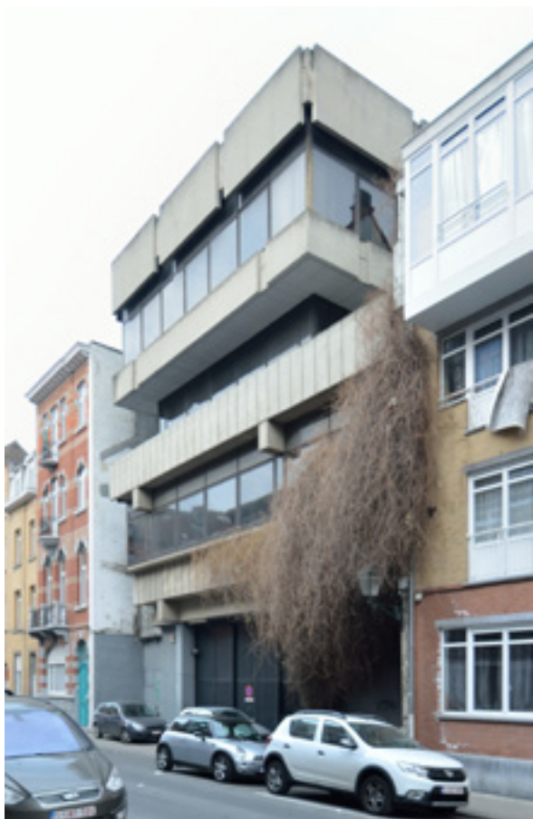
FIG. 13A Ancien siège et entrepôts S.A. Belge Cinzano rue de Belgrade n° 74 à Forest, arch. Groupe AUSIA, 1971 (Inventaire, 2019 © urban.brussels).
