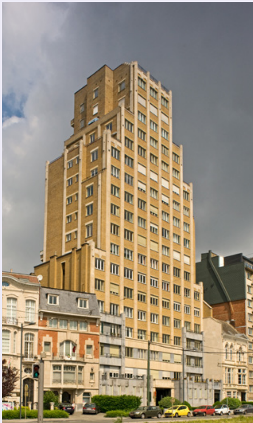
FIG. 3 Résidence de la Cambre ou « building américain » avenue Général Jacques à Ixelles, arch. Marcel Peeters, 1938-39 (A. de Ville de Goyet, 2012 © urban.brussels).
