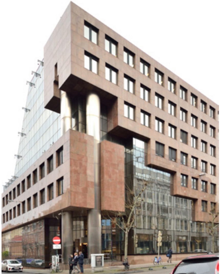
FIG. 10 Immeuble de bureaux avenue de Cortenberg n° 150 à Bruxelles, arch. ARCHI+I, 1988 (A. de Ville de Goyet, 2024 © urban.brussels).
