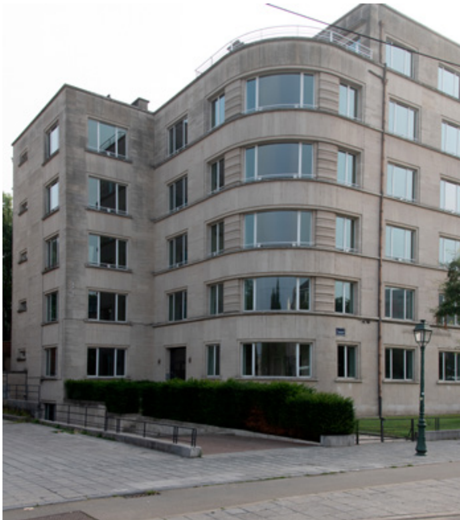
FIG. 7 Immeuble à appartements avenue de Tervueren n os 8-10-12, 14, 16-16a à Etterbeek, arch. André et Jean Polak et J. Saintenoy, 1949-1951 (A. de Ville de Goyet, 2024 © urban.brussels).
