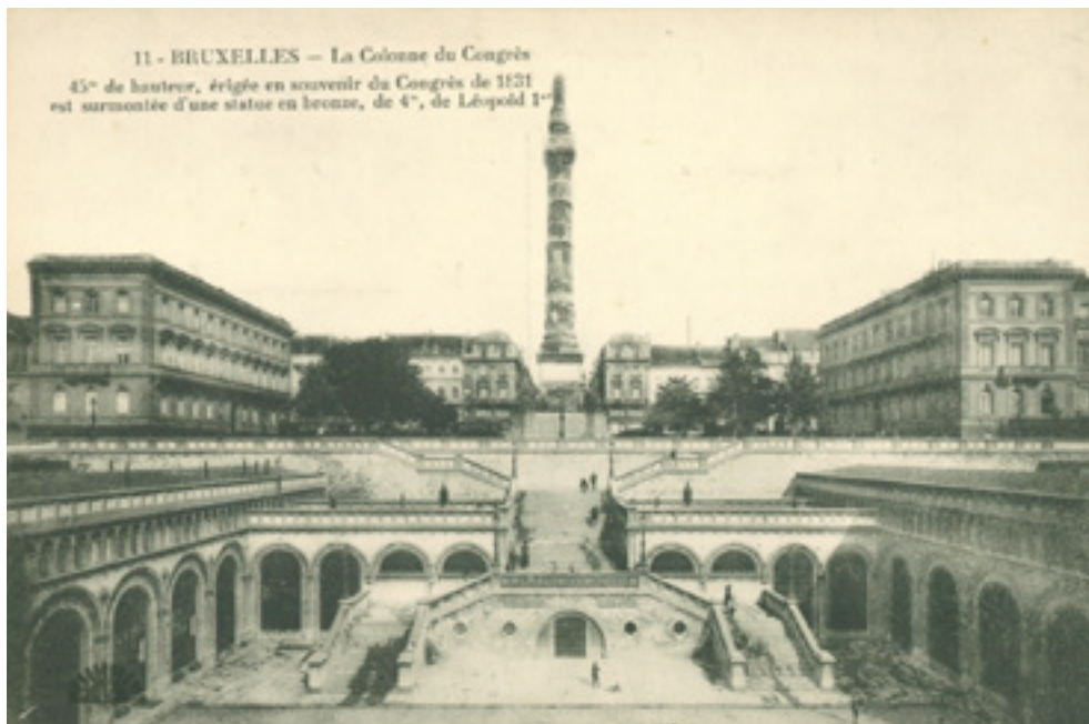
FIG. 9 Le marché du Parc et la place du Congrès vers 1900. Les aménagements urbanistiques sont ordonnés suivant un axe de symétrie qui traverse l'ensemble (© coll. Belfius Banque-Académie royale de Belgique © ARB - urban.brussels, DE04_284).
