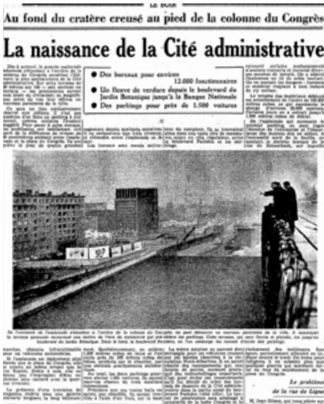
FIG. 13 L'esplanade de la Cité en cours de construction, extrait du journal Le Soir, 8 janvier 1961 (© KBR).
