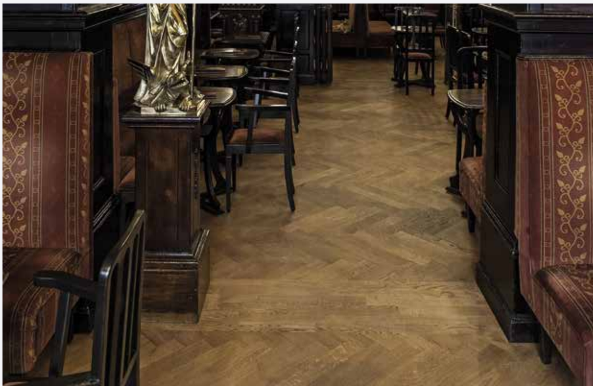
FIG. E.3.2 Parquet après travaux (A. de Ville de Goyet, 2018 © urban.brussels).
