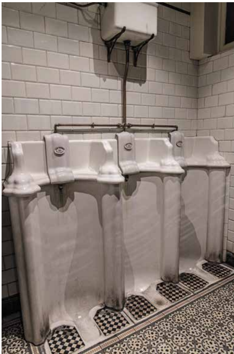
FIG. 16 Urinoirs, carrelages muraux et au sol restaurés (A. de Ville de Goyet, 2020 © urban.brussels).
