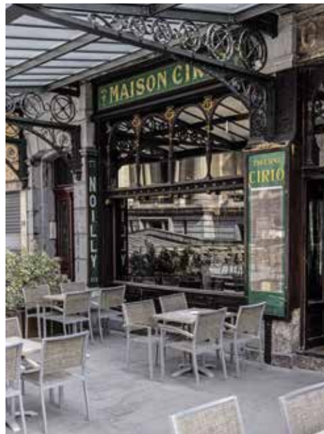
FIG. 5 Devanture du café Cirio après travaux (A. de Ville de Goyet, 2020 © urban.brussels).
