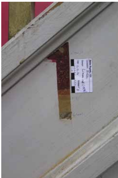
FIG. 2 Ancien atelier du peintre Arthur Rogiers, 103 rue Charles Quint, Bruxelles (Paul Hamesse, 1898), stratigraphie sur le limon de l'escalier de l'atelier (©photo de l'auteure, 2014).
