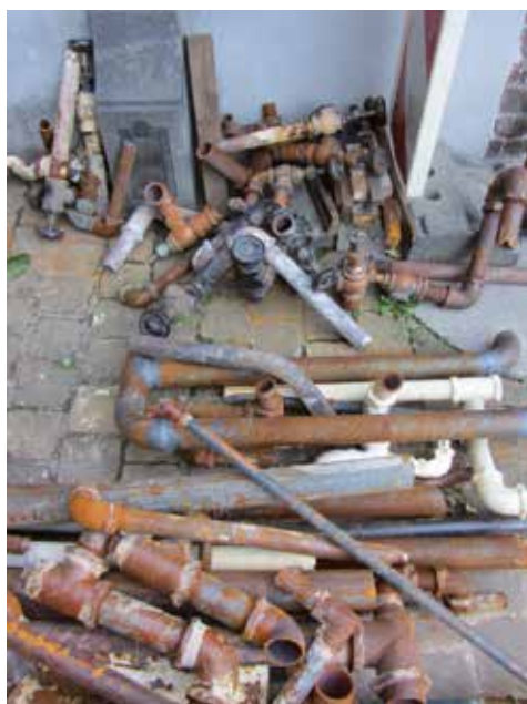
Tuyaux et robinets démontés avant d'être remplacés (photos de l'auteure).
