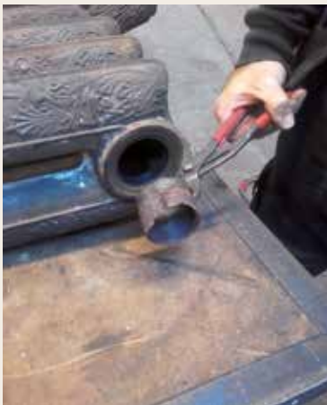
Démontage des anciennes nipples (photo Desmée-Guillou).
