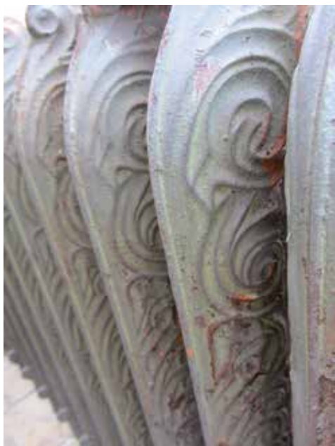
Partie arrière du radiateur (modèle Perfection ) de l'ancienne salle d'étude de l'hôtel Solvay dans ses couleurs d'origine : vert pâle ressuyé sur vert foncé (photo de l'auteure).
