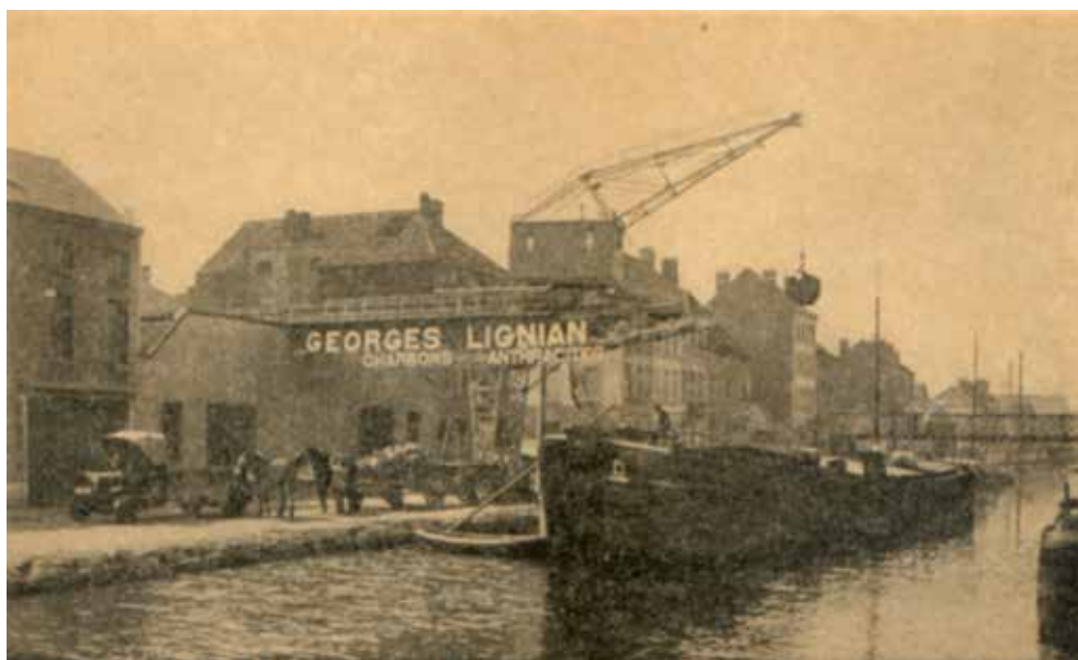
FIG. 3 Quai de chargement des péniches avec la grue du marchand de charbon et anthracites Georges Lignian, quai de l'Industrie, 55 à Bruxelles, vers 1920-1940 (coll. La Fonderie).
