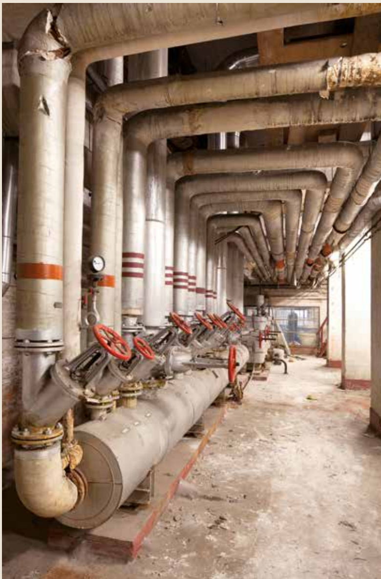
Réseau de conduits à vanne dans lesquels circulaient l'eau surchauffée en vapeur (© Helen Hermans, 2017).
