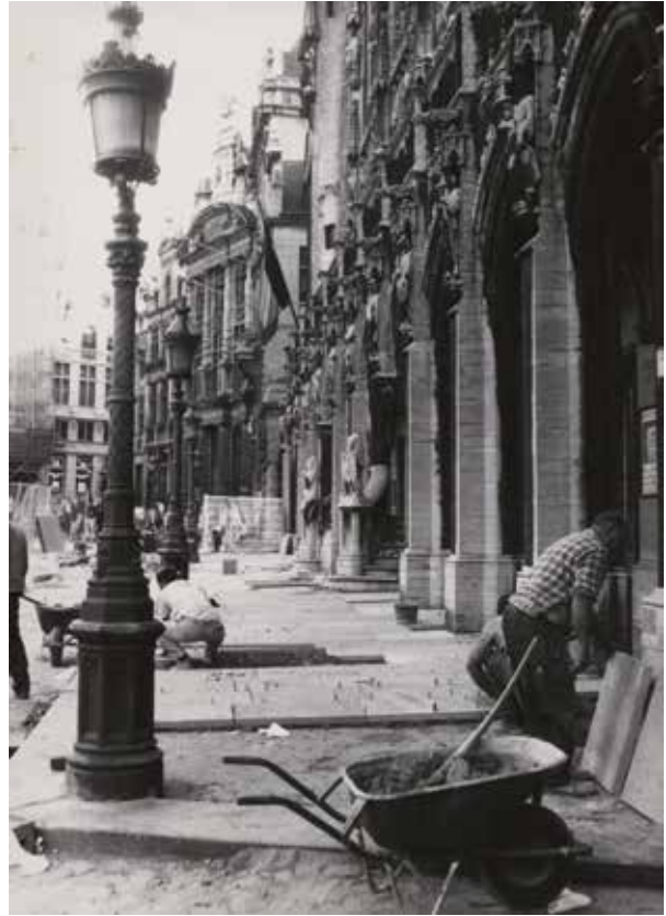
Fig. 12 Renouvellement du revêtement de trottoir de l'aile orientale. Sans date. La photo a été prise entre 1986 et 1990, comme en attestent les échafaudages du chantier de restauration des Ducs de Brabant visibles en arrière-plan (© AVB, FI C 19500).
