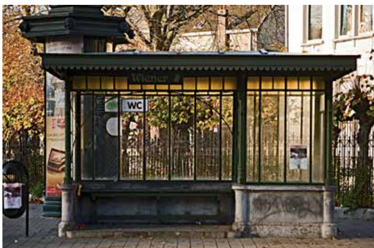
Fig. 13 Aubette de tram, anciennement sur la place communale, classée et déplacée en 2006 rue Major Brück (2006 © Urban.brussels).
