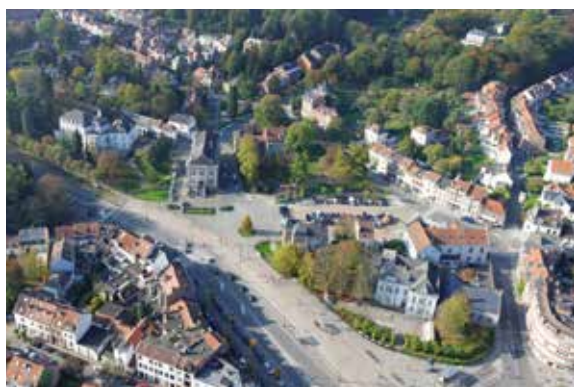
Fig. 4 La place communale et ses abords, où l'on repère l'ensemble des bâtiments repris dans la composition de Paul Delvaux (Globalview, 2011 © Urban.brussels).
