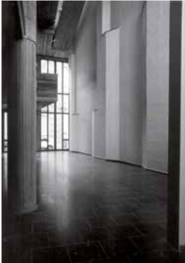
Fig. 30 Détail du mur en béton armé plissé côté rue Maurice Wilmotte, 1989 (© AUCL, Faculté LOCI/Fonds Jean Cosse).
