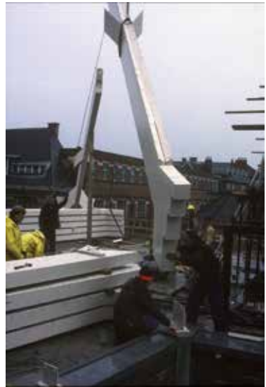
Fig. 18 Mise en place des éléments préfabriqués de la charpente au niveau de l'angle, 1989 (© AUCL, Faculté LOCI/Fonds Jean Cosse).
