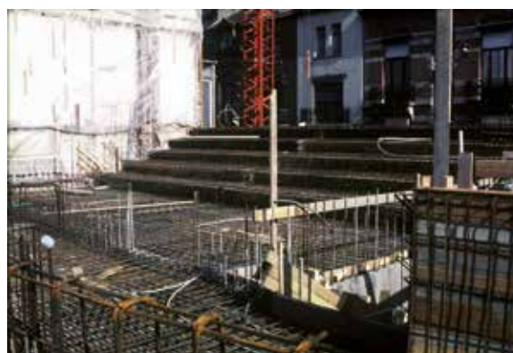
Fig. 13 Ferrailages des gradins, 1989 (© AUCL, Faculté LOCI/Fonds Jean Cosse).
