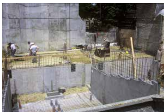
Fig. 7 Chantier au niveau sous-sol. Vue d'ensemble, 1988 (© AUCL, Faculté LOCI/Fonds Jean Cosse).
