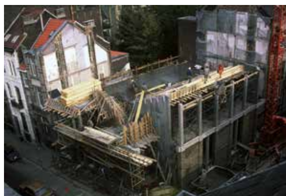
Fig. 15 Les gradins au deuxième niveau en construction, vue panoramique, 1989 (© AUCL, Faculté LOCI/Fonds Jean Cosse).
