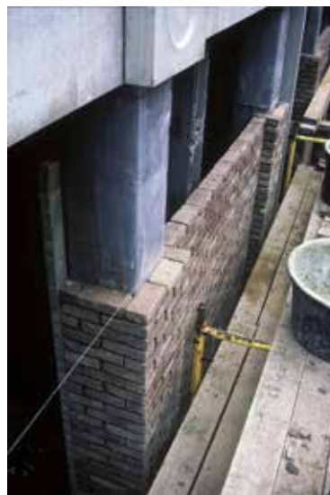
Fig. 11 Détail du mur de la façade en construction, 1989 (© AUCL, Faculté LOCI/Fonds Jean Cosse).
