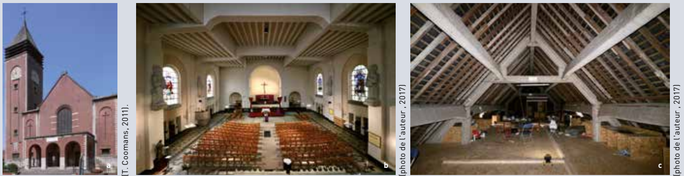
Fig. 2a à 2c : Église Saint-Pierre, Woluwe-Saint-Pierre : a) Façade ; b) Nef unique ; c) Charpente en béton armé
