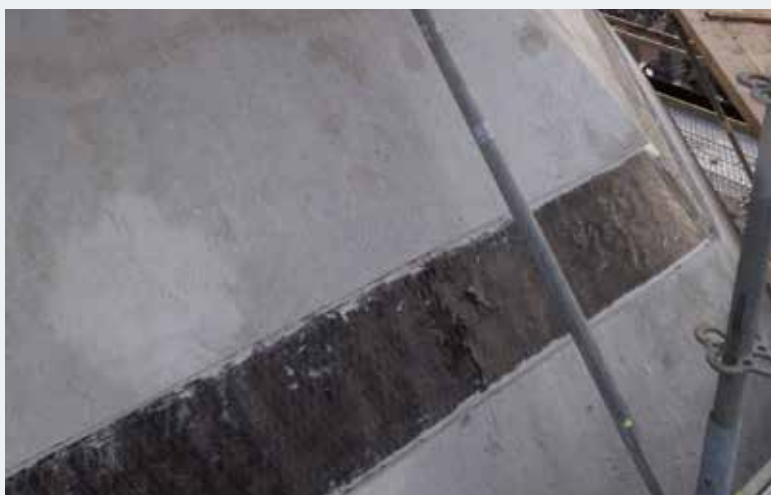
Fig. 20 Bande en fibres de carbone collée à l'extrados (2015 © Origin).
