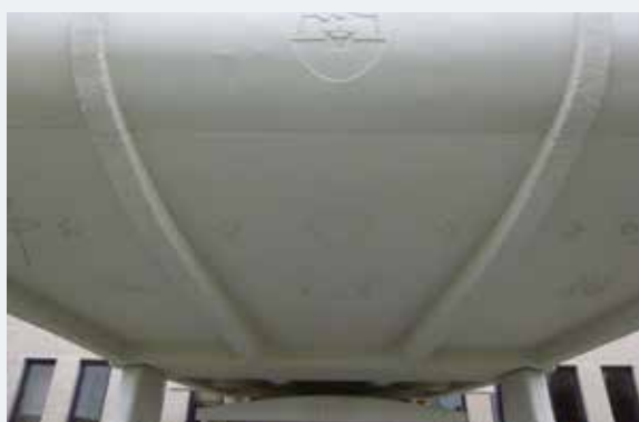
Fig. 23 Bandes de zinc collées en surface et connectées aux armatures (2015 © Origin).
