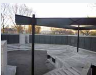
Fig. 11 Fin des travaux (2013 © Origin).
