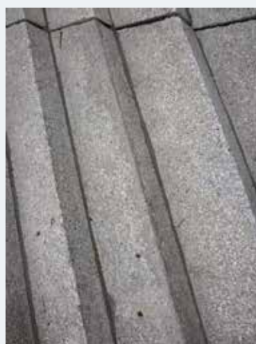
Fig. 9 Marches, après réparation avec ajout de graviers (2013 © Origin).
