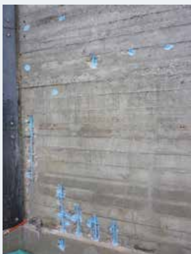
Fig. 7 Traitement des armatures (2013 © Origin).
