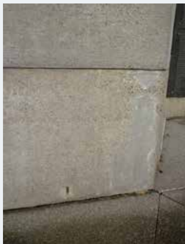
Fig. 4 Mémorial national aux Martyrs juifs de Belgique : avant les travaux, présence d'une ancienne réparation (2009 © Origin).
