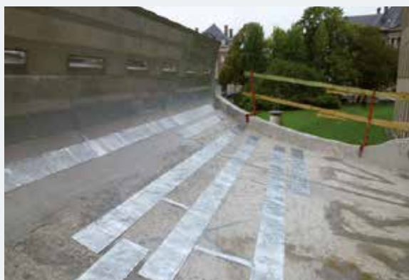
Fig. 23 Bandes de zinc collées en surface et connectées aux armatures (2015 © Origin).
