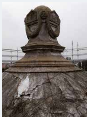
Fig. 18 Couple en début de chantier (2016 © Origin).
