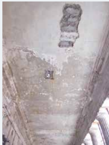
Fig. 15 Couverture d'une galerie, début des travaux (2015 © Origin).
