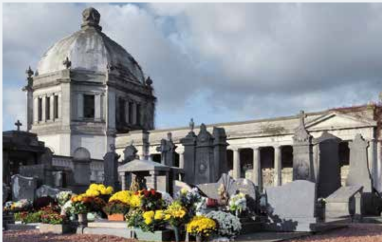
Fig. 14 État au début des études de restauration en 2009 (© Origin).
