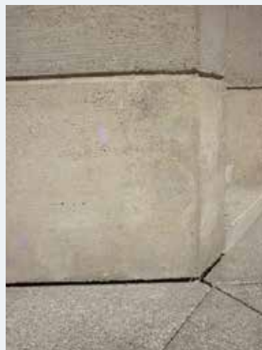
Fig. 6 Après les travaux, patine terminée (2013 © Origin).
