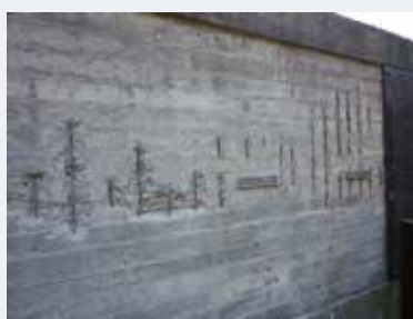
Fig. 10 Bétons fissurés décapés, dégagements des armatures avant réparation (2013 © Origin).
