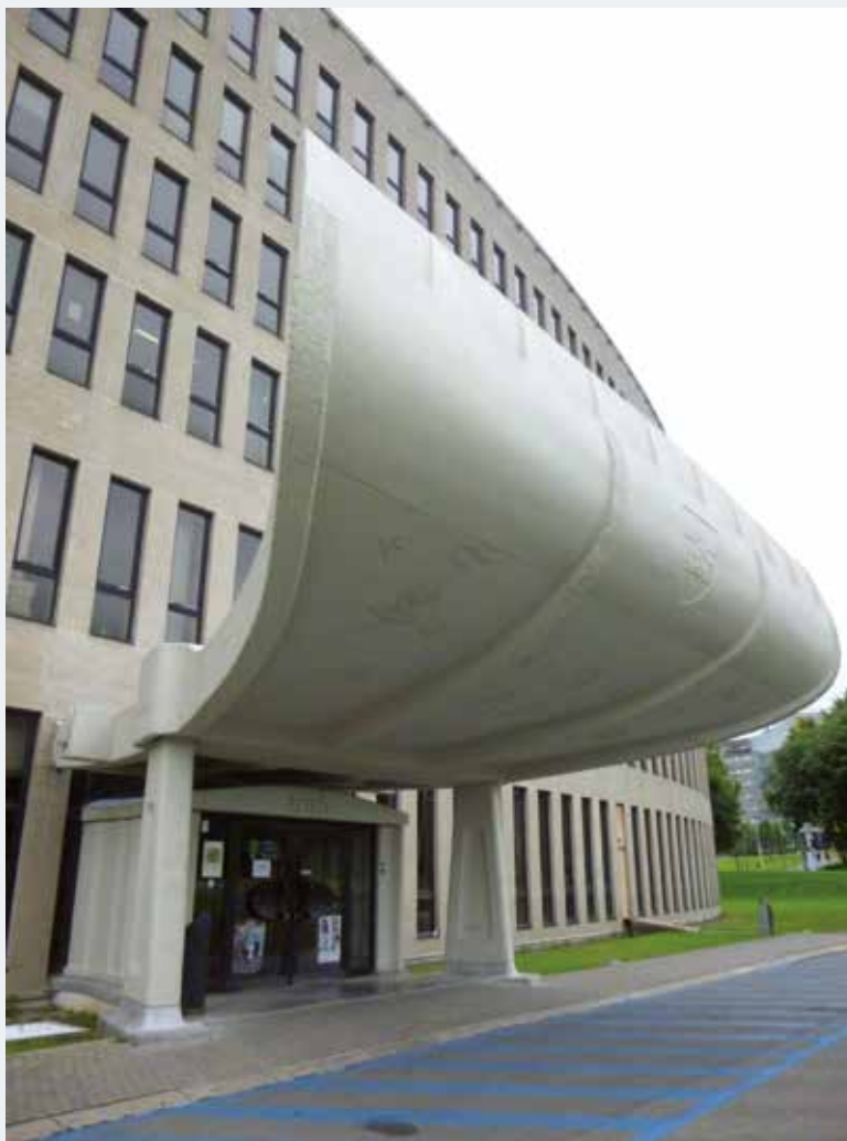
Fig. 2 Auvent du bâtiment M de la Vrije Universiteit Brussel (S. Duquesne, 2016 C Urban.brussels)
