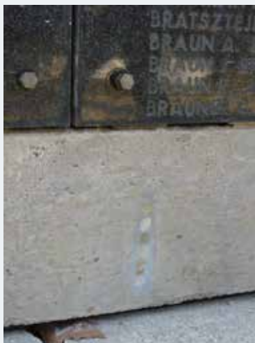
Fig. 5 Pendant les travaux, tests de patinage (2013 © Origin).
