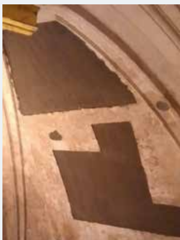
Fig. 19 Réparations locales à l'intrados (2015 © Origin).
