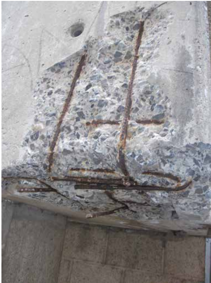
Fig. 3 Béton décapé en vue d'une réparation [2017 © Origin].
