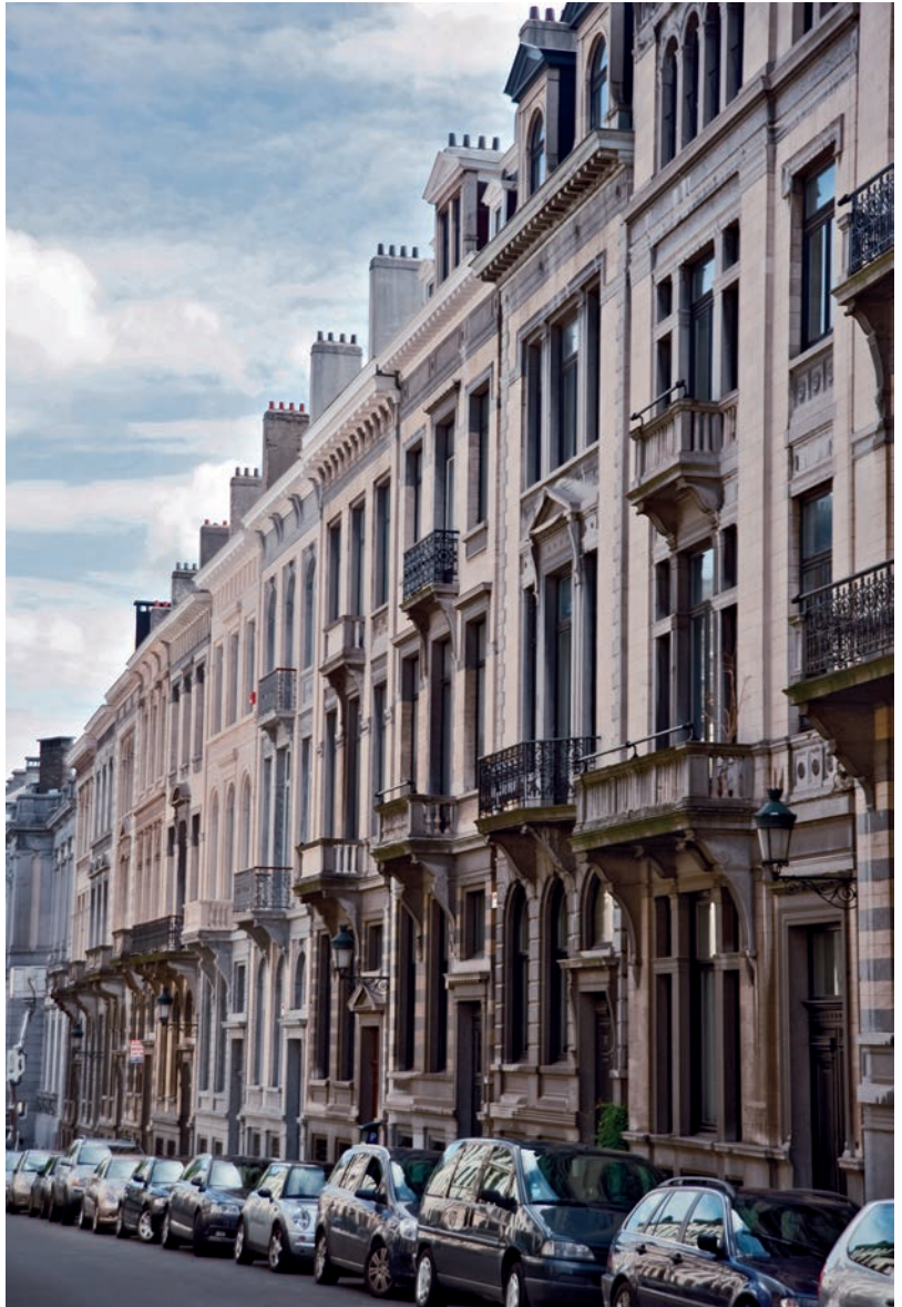
Fig. 13 Rue aux Laines. Vue d'un ensemble de façades (A. de Ville de Goyet, 2012 ©MRBC).
