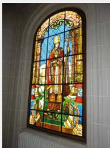
Fig. 12b Le vitrail restauré avec lightplate dans l'escalier d'honneur (E. de Sart, 2015 © urban.brussels).
