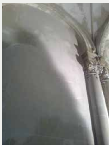
Fig. 9a État du simili-pierre au commencement des travaux [E. de Sart, 2013 © urban.brussels].
