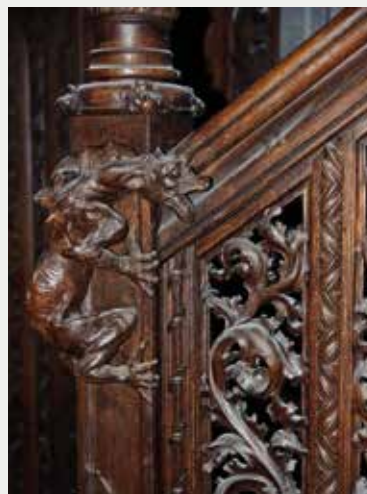
Fig. 13c Détail de la cage d'escalier [A. de Ville de Goyet, 2015 © urban.brussels].
