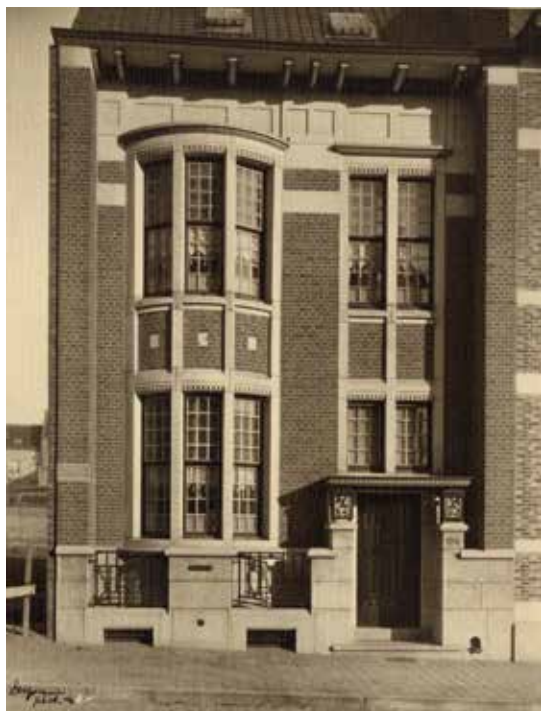
Fig. 8 Habitation bourgeoise rue des Cottages 156 à Uccle, 1922 (© coll. AAM / Fondation Civa Stichting Brussels).
