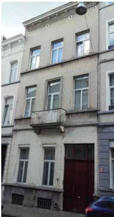
Fig. 3 Maison d'habitation de la rue de Locht 76 (photo de l'auteur, 2016).
