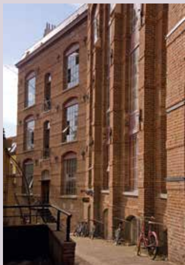
Les façades en brique et châssis métalliques confient au site son caractère industriel [A. de Ville de Goyet, 2011 © BUP/BSE].
