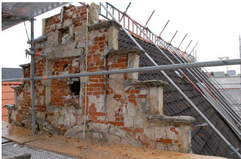
Fig. 4 Pignon rue au Beurre 30-32 à Bruxelles avant restauration (S. Modrie © SPRB-ULB).
