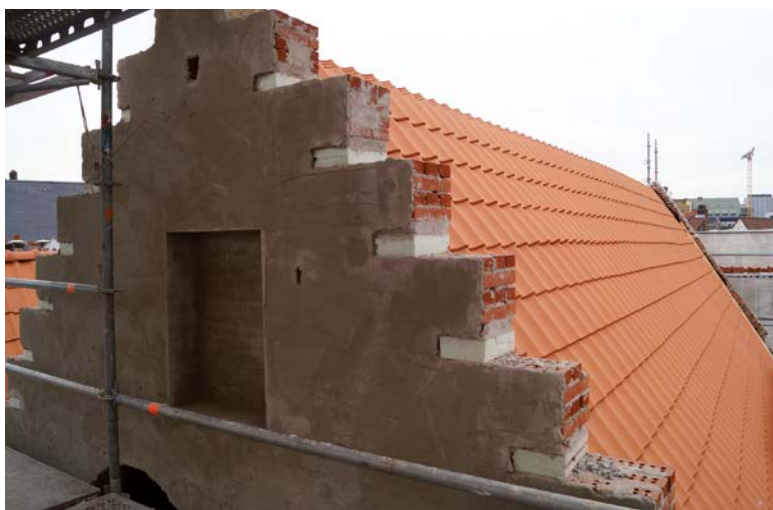
Fig. 5 Pignon rue au Beurre 30-32 à Bruxelles pendant la restauration : les documents archéologiques sont les seuls témoignages de la façade XVII e siècle, reconstruite en matériaux modernes (S. Modrie © SPRB-ULB).
