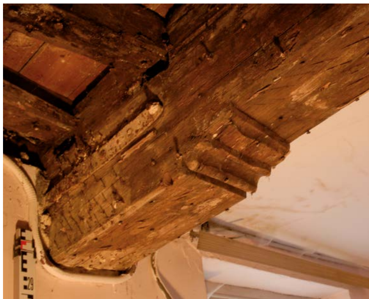
Fig. 7 Poutre de plancher présentant une moulure tardo-gothique, rue Haute 178 à Bruxelles (S. Modrie © SPRB-ULB).
