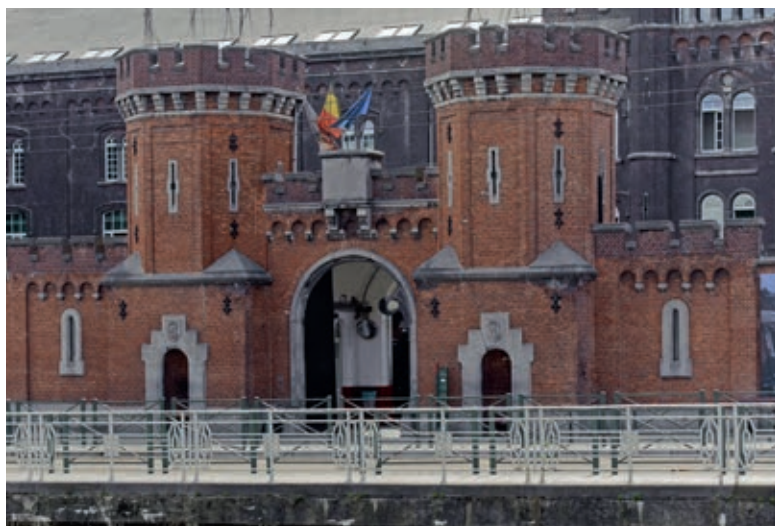
Fig. 6 Petiet-Château, Bruxelles (A. de Ville de Goyet, 2014 © SPRB).
