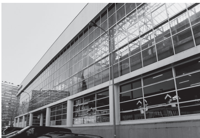
Fig. 14 Situation actuelle des ateliers vus de l'extérieur, en parallèle avec le canal de Willebroeck (Sami Bouchafrati, 2014 © RLICC).
