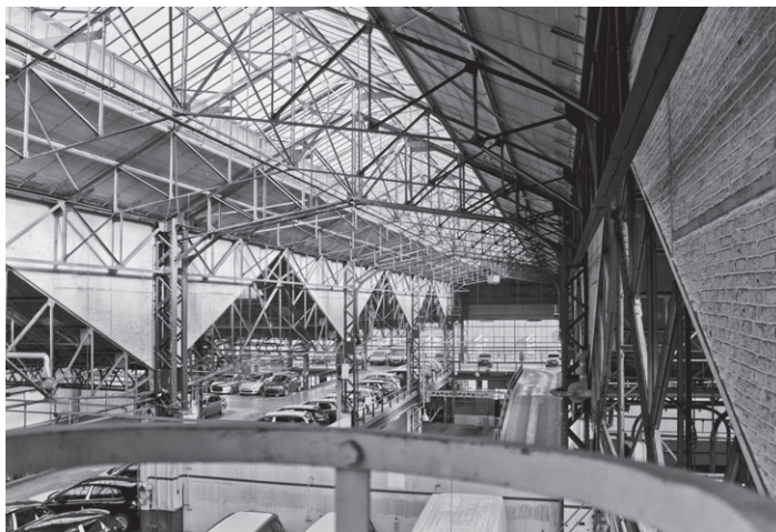
Fig. 13 Installation de la première plate-forme en béton dans les ateliers du côté du canal (ca. 1960, © ABCC).
