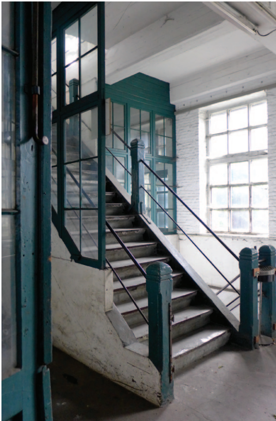
Fig. 14 Hall d'accès en bois vers l'atelier (photo de l'auteur).
