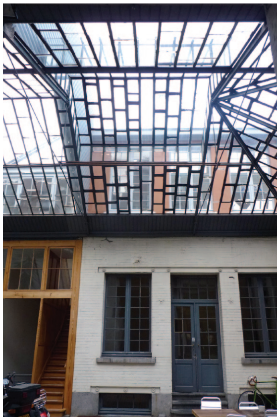
Fig. 3 Ancienne lustrerie Kaufmann, rue Locquenghien 55-57 à Bruxelles. Cour couverte sous verrière (© La Fonderie, 2015).
