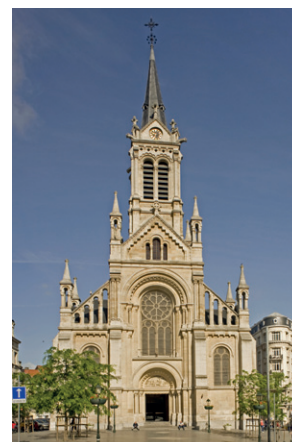
Fig. 11b Église Saint-Gilles, Saint-Gilles, (SG01) (A. de Ville de Goyet © SPRB).
