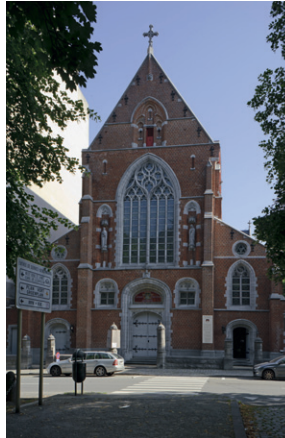
Fig. 16a Église et couvent des Dominicains, Bruxelles, (B006) (A. de Ville de Goyet © SPRB).
