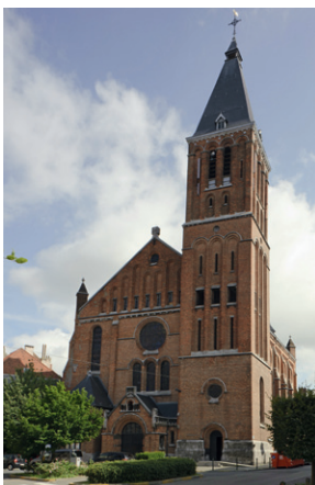
Fig. 18b Église du Sacré-Coeur à Etterbeek (1931-1935) [A. de Ville de Goyet, 2014 © SPRB].
