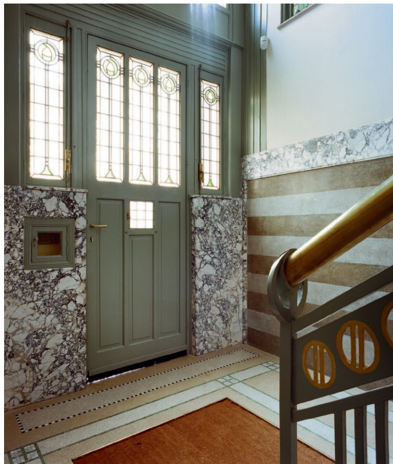
Fig. 9 Hall d'entrée (2014 © M.-Fr. Plissart).
