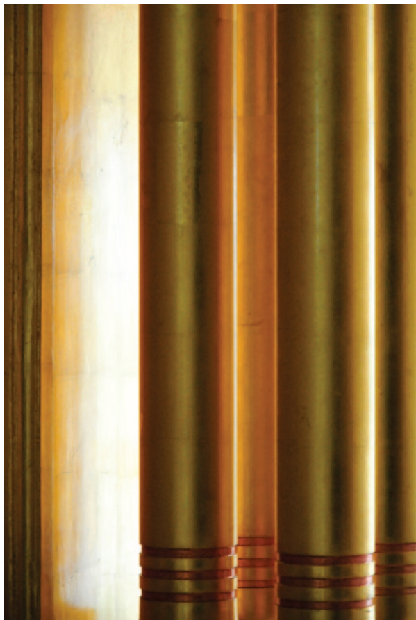
Fig. 1 Détail des colonnes dorées du salon, après restauration [© B. Baines].
