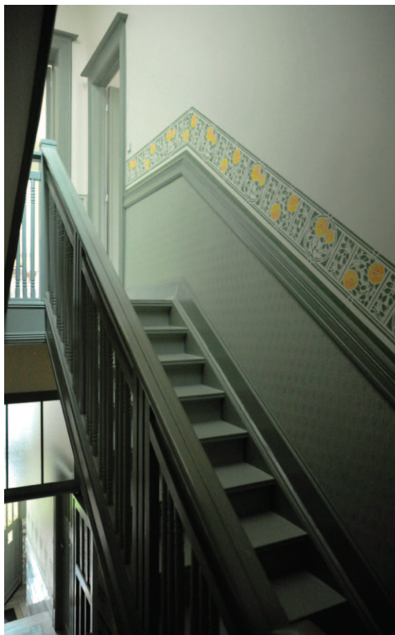
Fig. 12 Vue de la cage d'escalier depuis le palier de l'entre-sol (© B. Baines).
