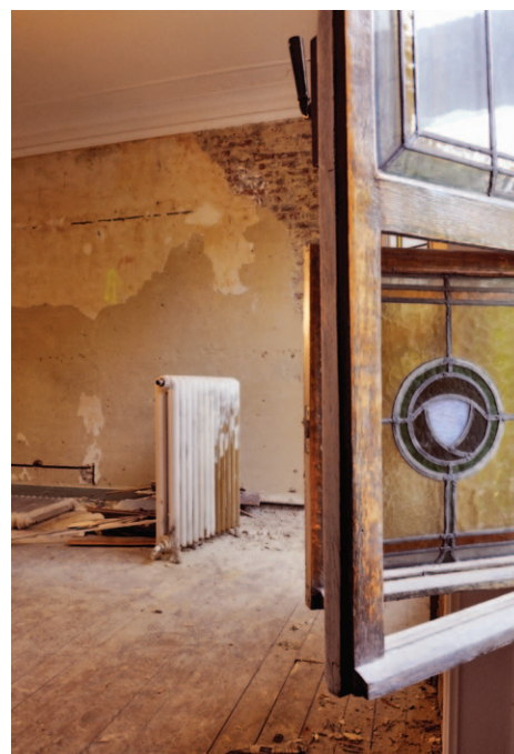
Fig. 1a Vue avant travaux (georgesdekinder.com © SPRB).
