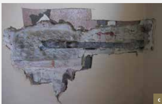
L'Âne. Ancre métallique. a) localisation des ancrages au moyen du détecteur de métal ; b) plaque carrée apparaissant en façade derrière le parement désagrégé ; c) décapage de l'enduit intérieur en vue d'observer la forme de l'ancre ; d) détail du scellement au plomb dans la pierre ; e) étude métallographique. Micrographie (a, b, c et d) : © CPH, 2001; e) : © VUB, 2001).
