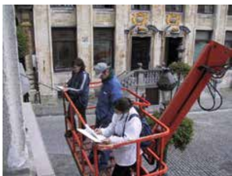
Inspections à l'aide d'une nacelle (© CPH, 2000).
