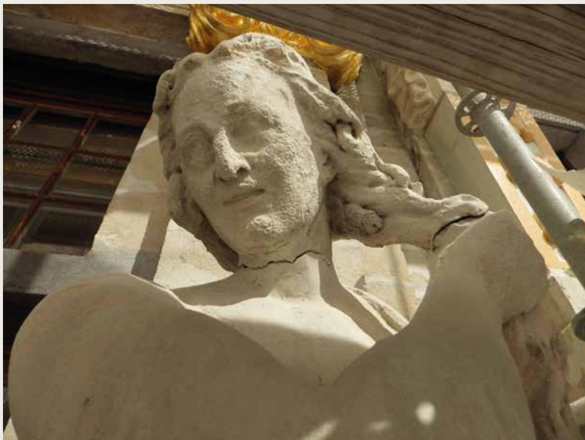
La Louve. Statue avec tête cassée (due à la corrosion d'un goujon) (© CPH, 2014).
