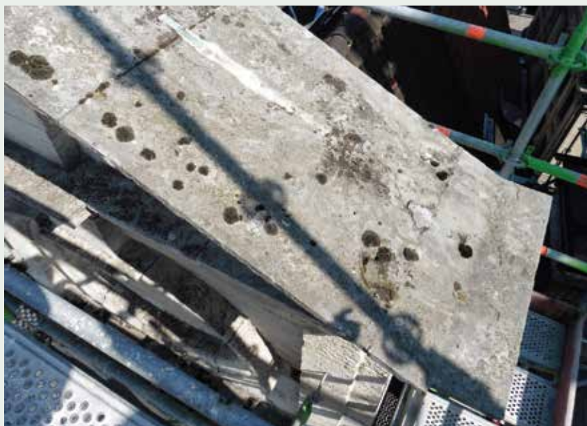
Le Heaume . Développement de mousses sur les rampants du fronton. Pierre de Gobertange (© CPH, 2015).
