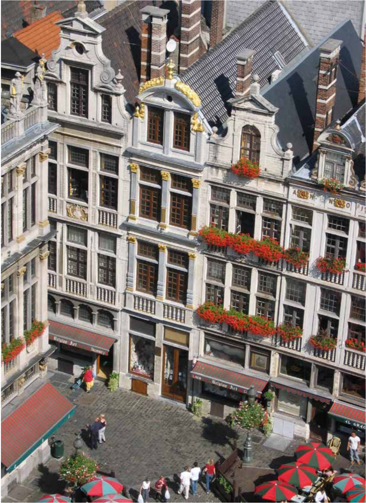
L'Âne. Après restauration de la façade (© CPH, 2004).
