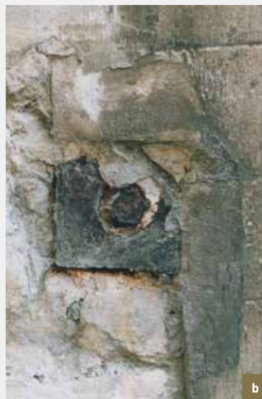
L'Âne. Ancre métallique. a) localisation des ancrages au moyen du détecteur de métal ; b) plaque carrée apparaissant en façade derrière le parement désagrégé ; c) décapage de l'enduit intérieur en vue d'observer la forme de l'ancre ; d) détail du scellement au plomb dans la pierre ; e) étude métallographique. Micrographie (a, b, c et d) : © CPH, 2001; e) : © VUB, 2001).
