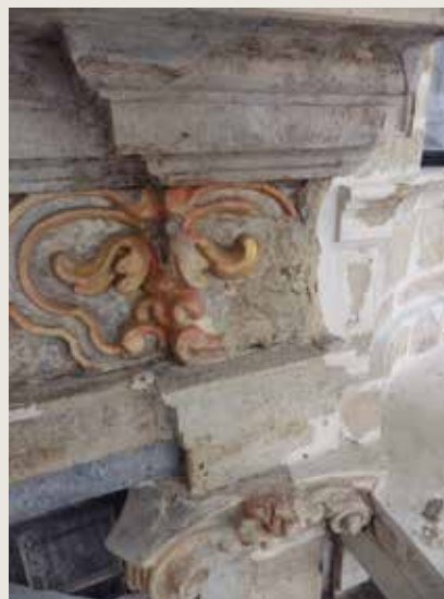
Le Renard. Pulvérulence d'une frise en pierre d'origine (pierre d'Avesnes?) (© CPH, 2012).
