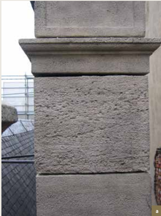
L'Étoile. a et b) dislocation et joints ouverts dans la pierre d'Euville suite aux problèmes structurels (poussée des éléments métalliques corrodés du plancher) (© CPH, 2008).
