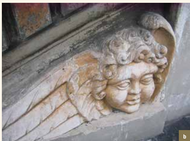
La Chaloupe d'Or. a) détail du fronton. Peinture et dorure écaillée; b) un ange. Peinture encrassée. Disparition de la dorure; c) détail des inscriptions du tympan. Enduit fissuré. Peinture disparue. Dorure dégradée; d) détail d'un piédestal de pilastre avec peinture et dorure écaillées (© CPH, 2012).
