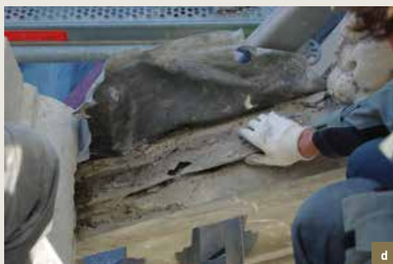
La Chaloupe d'Or. a) aileron de gauche avec motifs de fleurs. L'élément se détache et tend à glisser vers l'extérieur, suite à la corrosion d'une patte métallique ; b) idem. Partie de droite. Placement d'un filet de protection provisoire suite à l'inspection, en attente de travaux de restauration ; c) déversement du pinacle droit du pignon ; d) idem côté gauche. Sous le plomb, on constate la rouille de la patte métallique provoquant les désordres mentionnés (© CPH, 2000).
