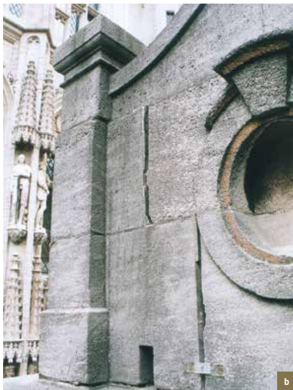
L'Étoile . Problèmes structurels. a) basculement du fronton du pignon de la façade côté Grand-Place. Pierre d'Euville; b) dislocation de pierres dans la façade arrière. Fissuromètre installé lors de l'état des lieux (© CPH, 2008).
