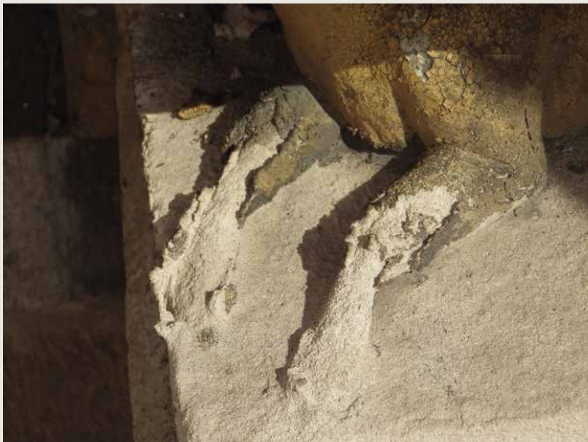
La Louve. Pulvériscence de la pierre d'Euville sur un élément sculpté (© CPH, 2014).
