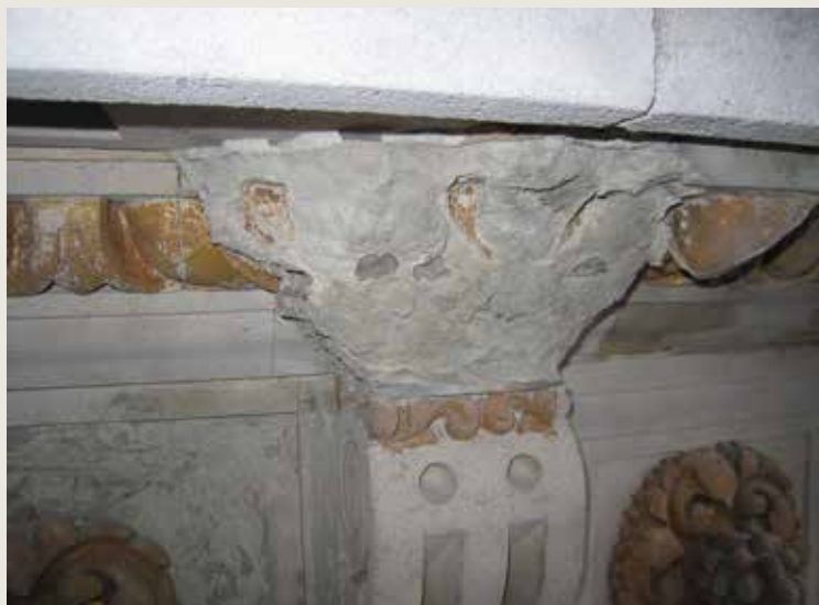
Le Cygne. Pulvérulence de la console (pierre d'Avesnes?) (© CPH, 2008).
