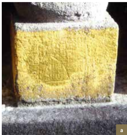
Marques de pierre. a) L'Âne. Marque de pierre sur un dé en pierre bleue ; b) La Brouette. Pierres numérotées. Pierre de Balegem ; c) La Maison des Brasseurs. Marque de pierre sur l'arrière d'un dauphin sculpté en pierre bleue (© CPH, 2002 et 2014).
