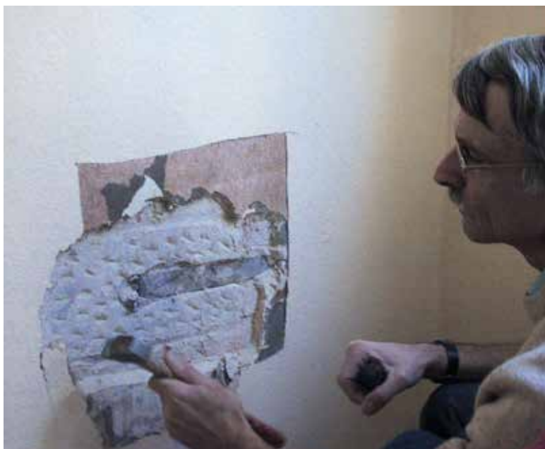
L'Âne . Sondage du mur mitoyen en vue d'observer la forme de l'ancrage par A. Pien (© CPH, 2001).
