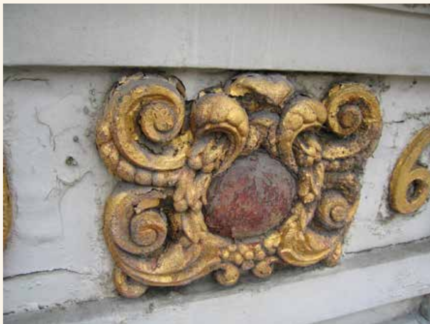
Le Petit Renard et le Chêne. Les médaillons avec boursofflures dans la peinture, écaillage de la dorure, encrassement généralisé (© CPH, 2014).
