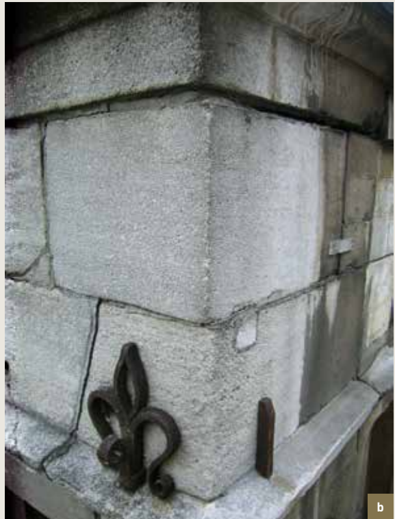
L'Étoile. a et b) dislocation et joints ouverts dans la pierre d'Euville suite aux problèmes structurels (poussée des éléments métalliques corrodés du plancher) (© CPH, 2008).
