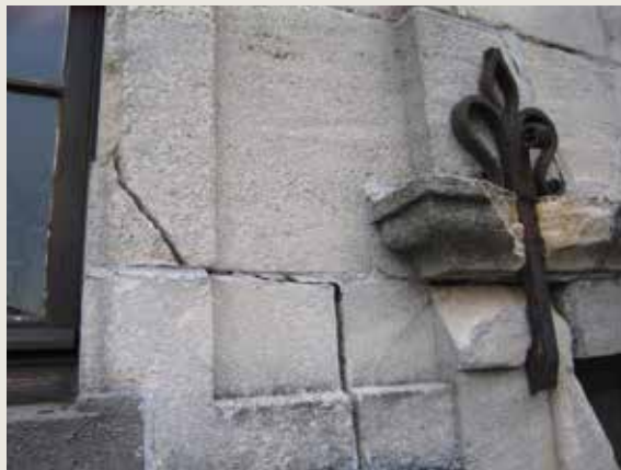
Joseph et Anne. Lézarde dans le parement en pierre d'Euville (© CPH, 2000).
