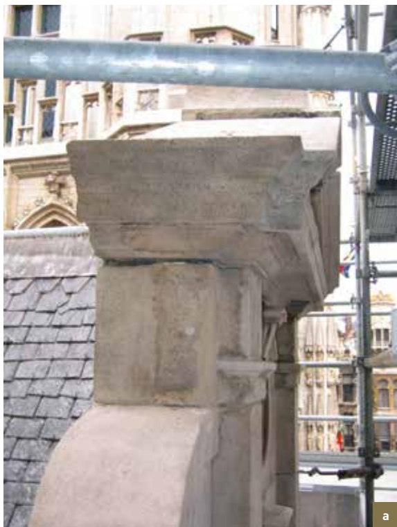
L'Étoile . Problèmes structurels. a) basculement du fronton du pignon de la façade côté Grand-Place. Pierre d'Euville; b) dislocation de pierres dans la façade arrière. Fissuromètre installé lors de l'état des lieux (© CPH, 2008).
