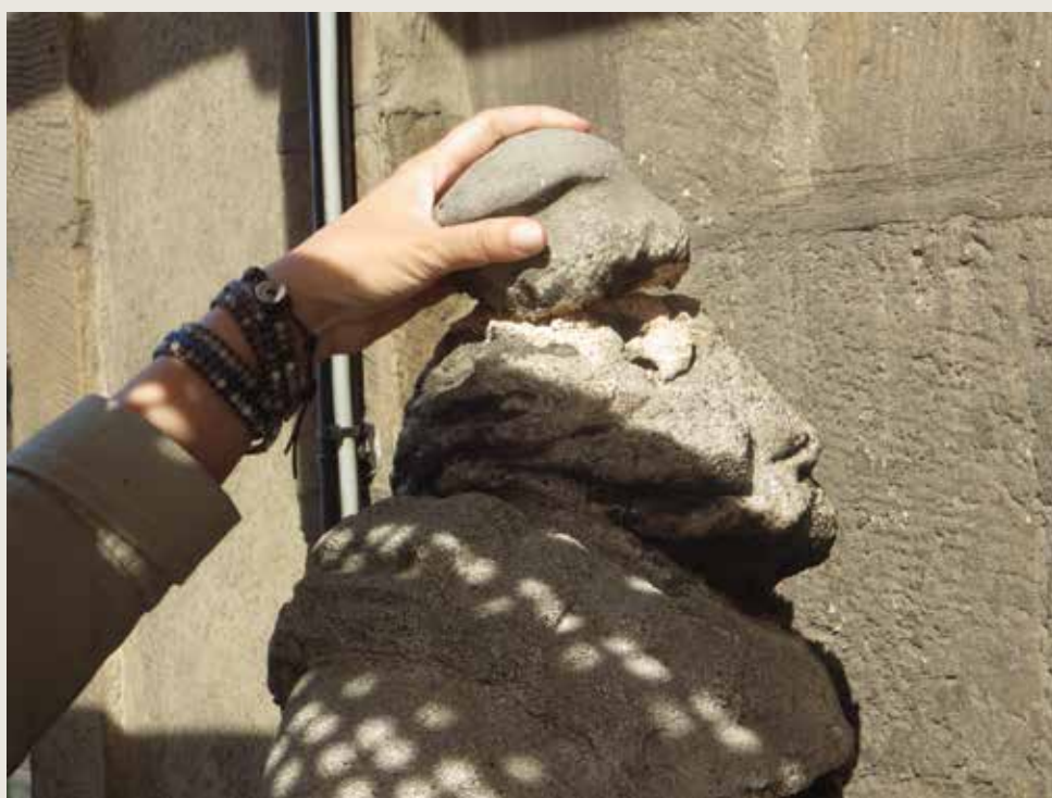
La Louve. Pulvériscence de la pierre d'Euville sur un élément sculpté (© CPH, 2014).
