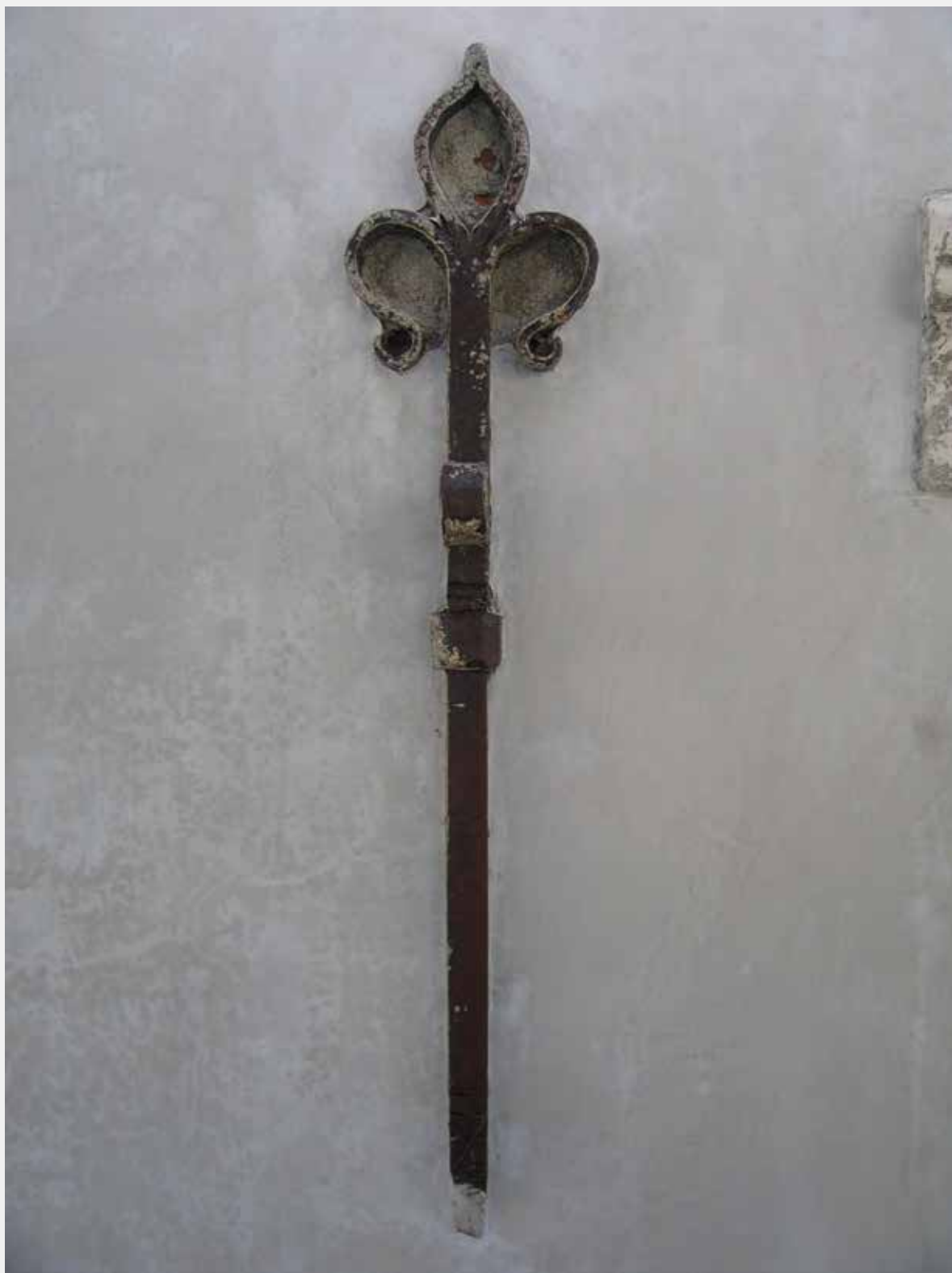
Le Mont Thabor. Façade latérale enduite. Ancrage métallique (© CPH, 2008).
