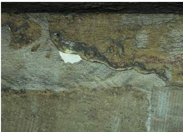
La Maison des Brasseurs. Prise d'échantillon de mortier de réparation (© CPH, 2002).
