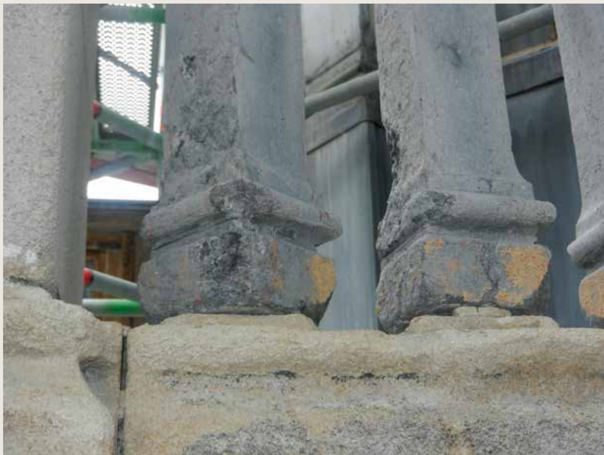
Le Roi d'Espagne. Chancre de la pierre, suite à la présence de stylolithes et à la pose des balustres en délit. Pierre bleue (© CPH, 2014).
