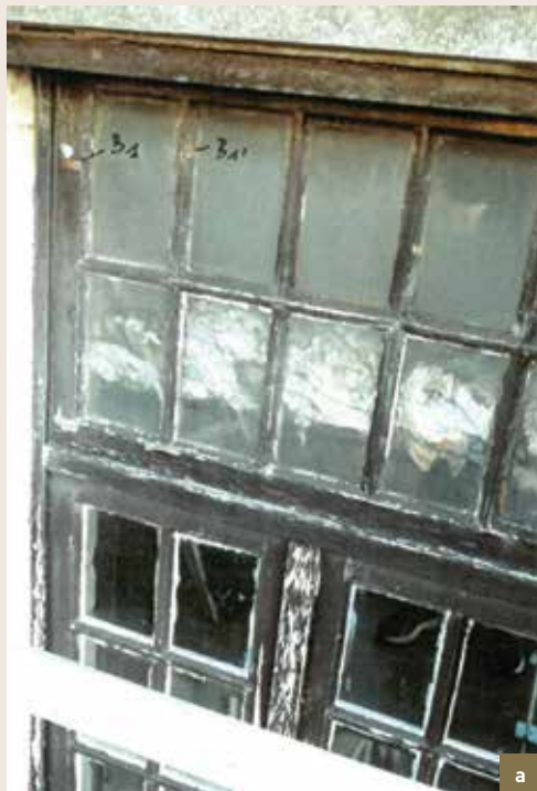
L'Âne . a, b et c) sondage stratigraphique et macrophotographie d'un châssis indiquant un vernis comme couche originale a et b) © M. Decroly, 2002 ; c) © KIK-IRPA, 2002).
