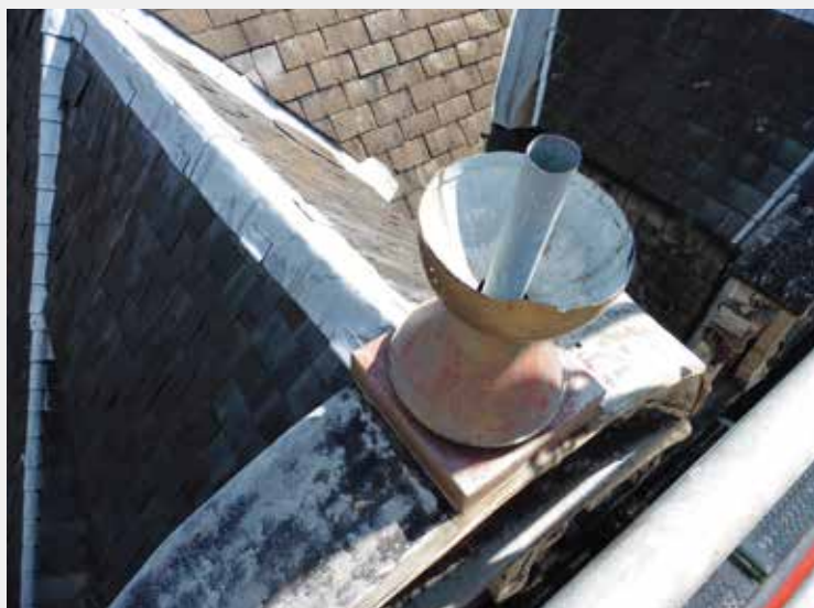
Le Petit Renard et Le Chêne. Un vase cassé en deux, suite à la corrosion du zinc (© CPH, 2015).
