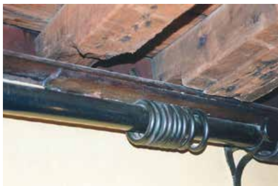
L'Ange – entresol, cornières en acier supportant les anciens gîtes (© CPH, 1999).
