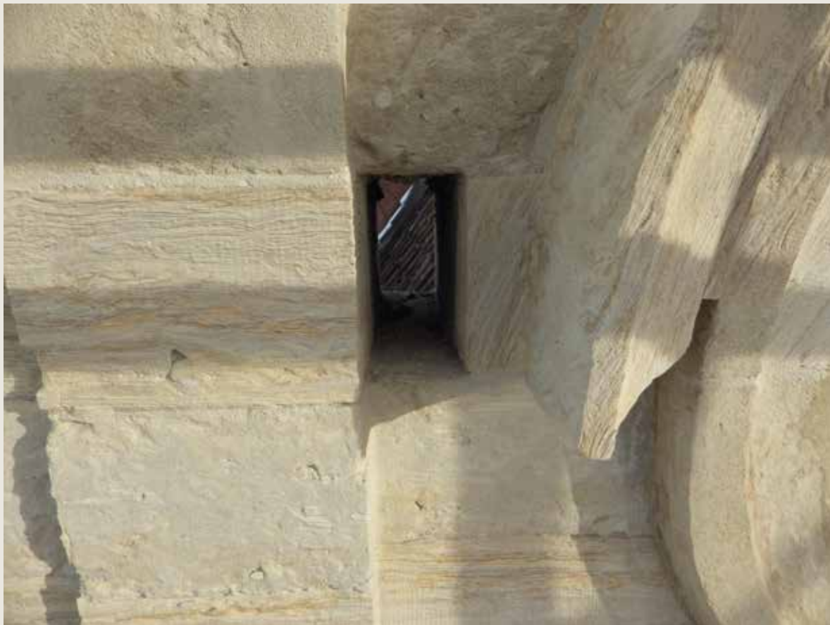
Le Heume. Détail du pignon en pierre de Gobertange laissant apparaître les bioturbations caractéristiques de cette pierre (© CPH, 2015).
