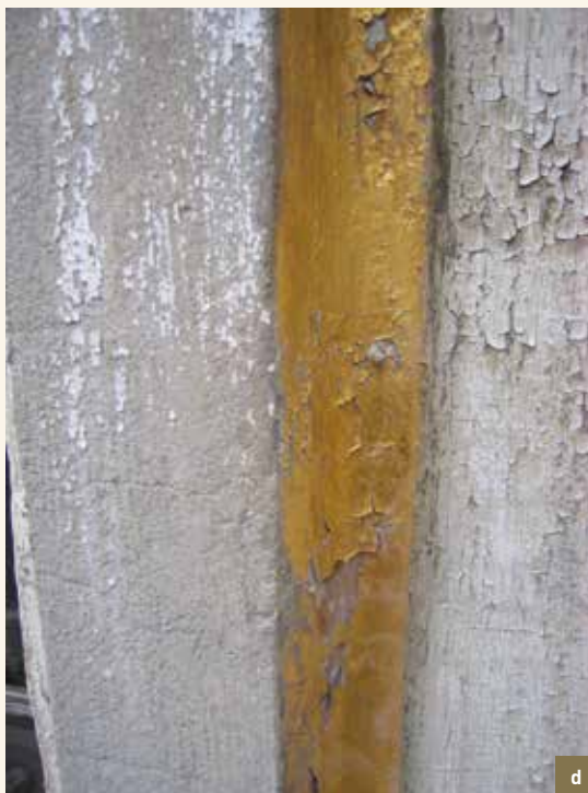
La Chaloupe d'Or. a) détail du fronton. Peinture et dorure écaillée; b) un ange. Peinture encrassée. Disparition de la dorure; c) détail des inscriptions du tympan. Enduit fissuré. Peinture disparue. Dorure dégradée; d) détail d'un piédestal de pilastre avec peinture et dorure écaillées (© CPH, 2012).
