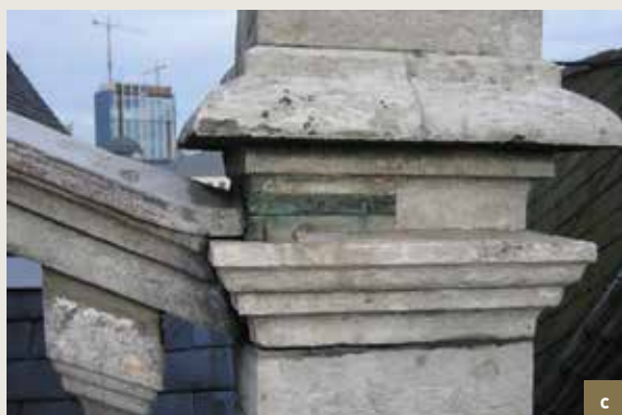
La Chaloupe d'Or. a) aileron de gauche avec motifs de fleurs. L'élément se détache et tend à glisser vers l'extérieur, suite à la corrosion d'une patte métallique ; b) idem. Partie de droite. Placement d'un filet de protection provisoire suite à l'inspection, en attente de travaux de restauration ; c) déversement du pinacle droit du pignon ; d) idem côté gauche. Sous le plomb, on constate la rouille de la patte métallique provoquant les désordres mentionnés (© CPH, 2000).
