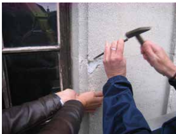
La Maison des Brasseurs. Prise d'échantillon de mortier de réparation (© CPH, 2002).
