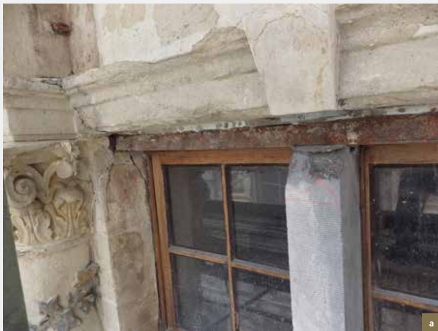
La Brouette. Barres métalliques de section carrée dédoublant les linteaux. Leur corrosion provoque la cassure des pierres. a) cassures d'éléments en pierre bleue et pierre de Balegem. Photographies prises en cours de chantier ; b) cassure d'un élément en pierre d'Euville. [© CPH, 2014]
