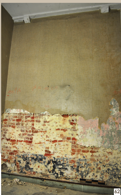
62 Mur pignon du théâtre Toone (US 1049) visible depuis la pièce nord-ouest de la maison B, l'enduit d'origine est couvert d'une peinture blanche et noire à hauteur du subsossement. Deux corbeaux de bois soutiennent la poutre (lambourde) de plancher du 2 e étage, photo : P. Gautier.
