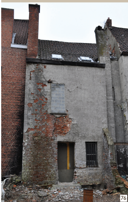
75 La fenêtre US 1029 était jadis plus grande, on a le seuil / appui de la baie en bois dans la maçonnerie, les ancrs et la poutre médiane, photo : P. Gautier. © urban.brussels
