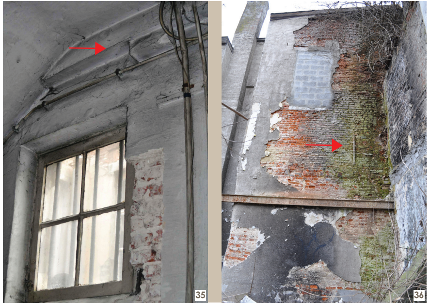
35 La fenêtre du premier étage, vers le pignon oriental, surmontée d'un corbeau de bois soutenant une des poutres (lambourde) du plancher du deuxième étage, photo : P. Gautier.
