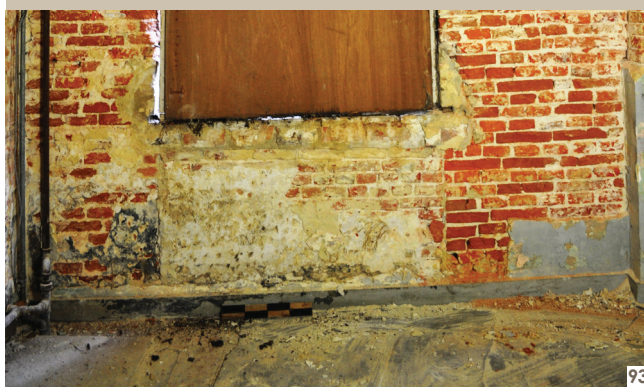
92 Au niveau du 1 er étage, la maçonnerie du mur pignon de la maison A, visible depuis la pièce nord-est de la maison B présente une partie saillante en encorbellement. Celle-ci est identifiée comme « maçonnerie d'attente » à la construction de la maison B. En effet, la maison B est plus large que la maison A et rattrape, de ce fait, l'alignement de façade du théâtre Toone (préexistante). Cette saillie dans la maçonnerie permet certainement de mieux ancrer la maison B, ente la maison A et le théâtre, vers le nord à l'endroit où elle est plus large que la maison A, photo : P. Gautier. © urban.brussels
