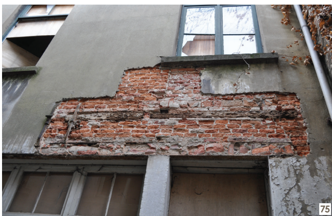
75 La fenêtre US 1029 était jadis plus grande, on a le seuil / appui de la baie en bois dans la maçonnerie, les ancrs et la poutre médiane, photo : P. Gautier. © urban.brussels
