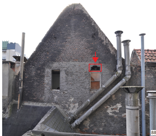
88 Pignon oriental, à hauteur du 1 er étage, la fenêtre d'origine ( US 1006 ) est bouchée, photo : P. Gautier. © urban.brussels
