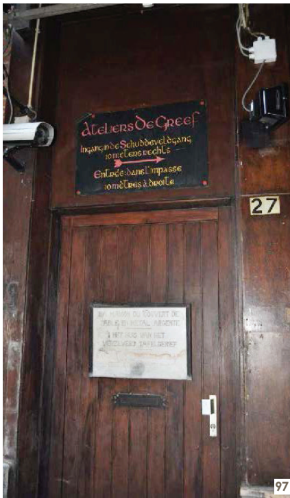
97 Enseignes à rue sur la porte du n° 27 Petite rue des Bouchers, photo : P. Gautier © urban.brussels
