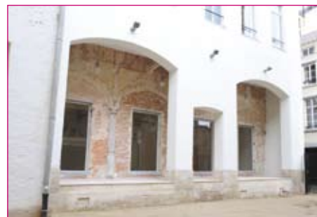
Les vestiges dégagés de la galerie gothique de l'hôtel d'Hoogstraeten enserrés dans le soubassement des façades blanches des bâtiments de la fin du 18 e s.
