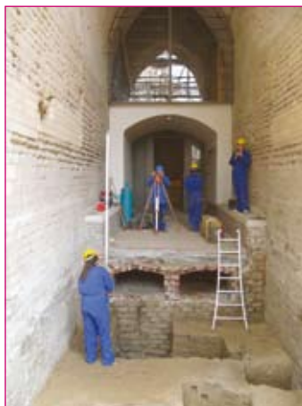
Porte de Hal. Fouille et relevé de la fosse interne du pont-levis, 2007.
