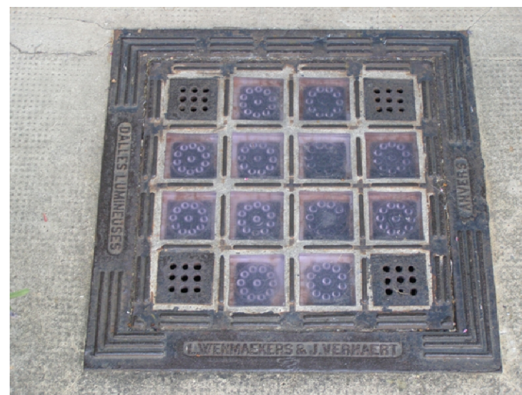
P7180043 - Wielewaalstraat nr. 40 rue du Loriot n°40
