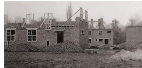
D'autres techniques nouvelles sont utilisées. Par exemple, la pose de petits châssis autoporteurs alignés dans le plan de la façade et montés en même temps que la maçonnerie.
