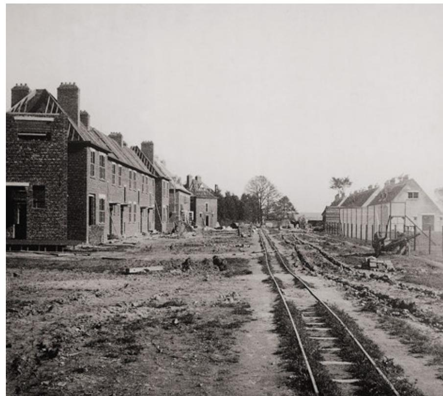
Pour réduire le coût de construction, le Comptoir national des Matériaux négocie la fabrication de certains matériaux de base sur le site du chantier. Profitant de la qualité du sol du Plateau, les briqueteries s'y installent dès 1922. Les briques cuites sont transportées à l'aide de carrioles tirées par un cheval ou grâce à un réseau de rails pour wagonnets. Photos 1922.
