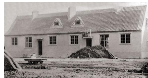
Les briques produites sur le chantier n'étant pas de qualité suffisante pour être utilisées en parement nécessitent une protection. L'enduit rugueux a le mérite d'unifier le volume de la maison tout en cachant les différents matériaux. Vue de l'avenue de l'Arbalète, Le Logis. Photos 1922-1923.
