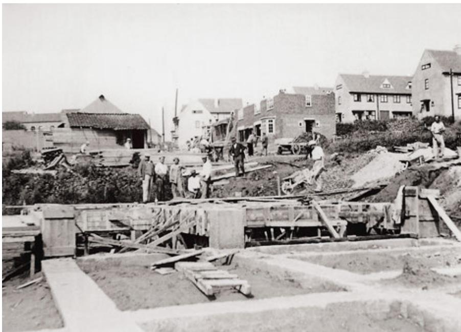
Le béton, coffré, est utilisé pour les fondations et sous forme de poutre pour le plancher du rez-de-chaussée des maisons sous caves, Le Logis.
