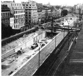
Le creusement des tunnels sous les carrefours (ici avec la rue de la Loi) constituait le préliminaire indispensable à la transformation des boulevards extérieurs en autoroute urbaine, décidée en prévision de l'Exposition de 1958.
