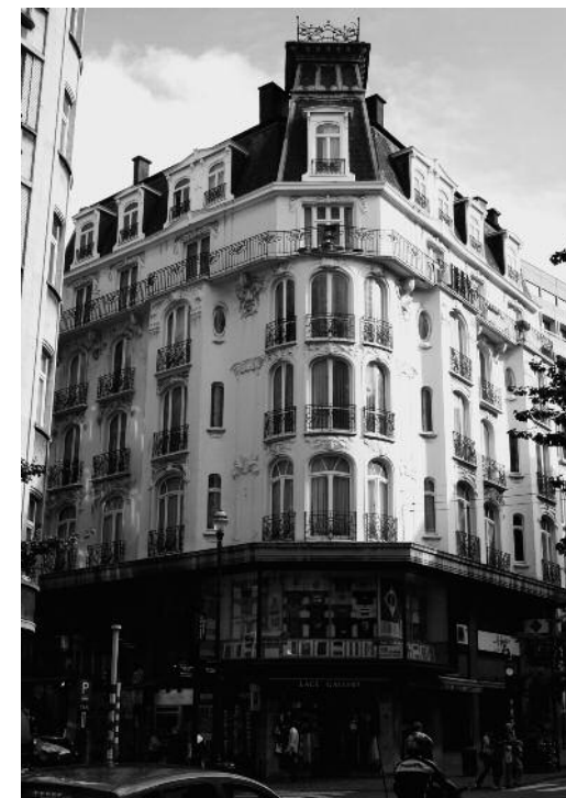
Paul Vizzavona, rue du Lombard 30-32, Bruxelles, 1909. Immeuble à appartements avec commerces.
