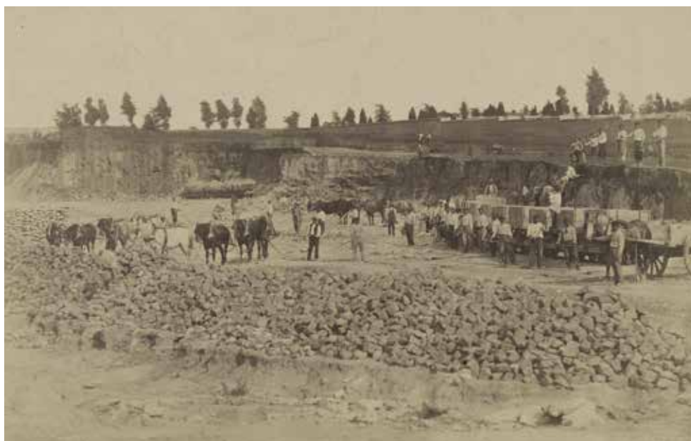
FIG. 3 Travaux de nivellement le long de l'avenue Louise, photographie de Charles Neyt (© AGR, iconographie 2579).
