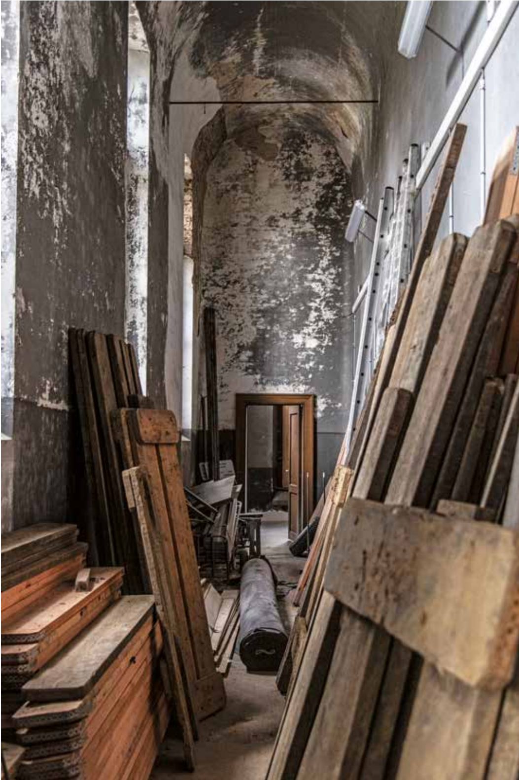
FIG. 8A Vue actuelle du couloir sud au rez-de-chaussée (A. de Ville de Goyet, 2020 © urban.brussels).
