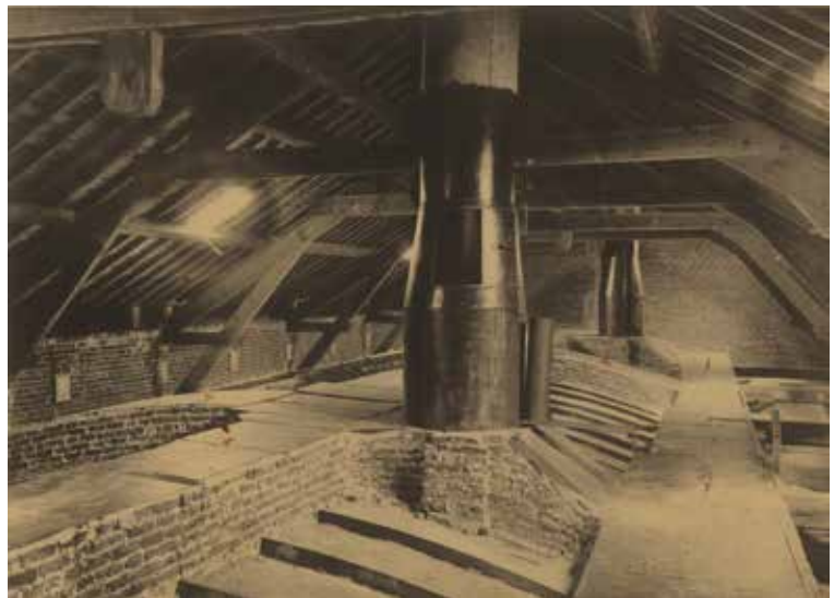
FIG. 6 Photo des foyers d'extraction de l'air du dépôt mortuaire, prise suite à l'achèvement du bâtiment, s.d. (© AVB).
