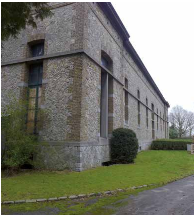
FIG. 2B Façade ouest et sud en 2015 (photo de l'auteur).
