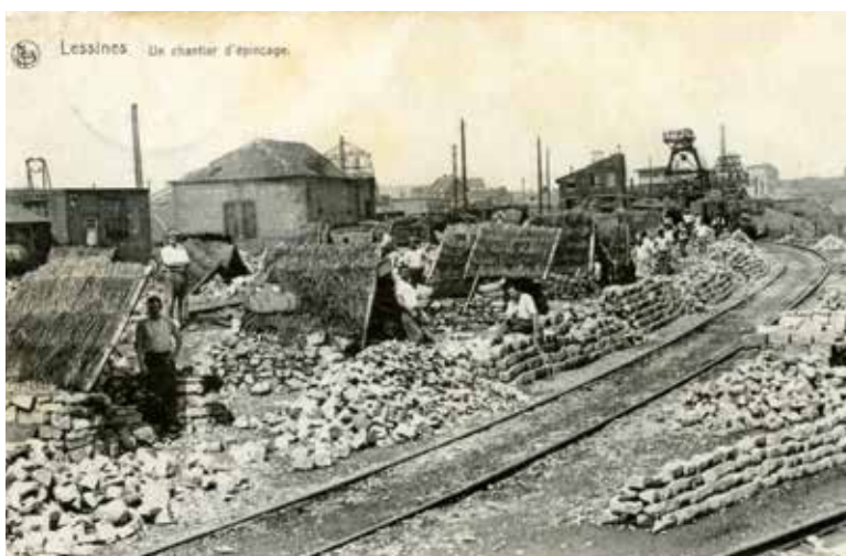
Fig. 3b Lessines, vue globale d'un chantier d'épincage des pavés. Les huttes de paille sont destinées à protéger les ouvriers des intempéries et du soleil. Les milliers de pavés produits, soigneusement empilés, seront d'abord transportés par des chemins de fer internes (carte postale Nels, collections anciennes © PMW).
