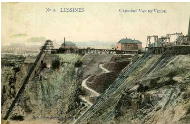
Fig. 3a Lessines, carrières Van de Velde. On y voit l'infrastructure utile à la gestion de l'importante dénivellée vers le « trou » profond de la carrière, de gauche à droite : un « descendeur », un chemin en zigzags pour les ouvriers et de longues rampes à rails, avec des machines à vapeur accompagnées de hautes cheminées (collections anciennes © PMW).
