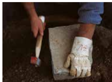
Fig. 5b Détail du geste ancestral d'épinçage, destiné à rectifier les arêtes des moellons et pavés et à perfectionner leur équerrage (© PMW).
