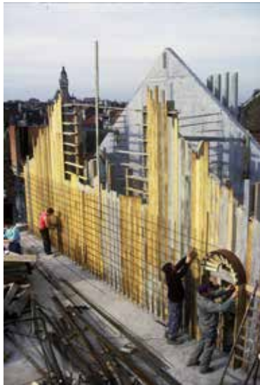
Fig. 16 Coffrage du voile en béton armé de la partie supérieure, 1989 (© AUCL, Faculté LOCI/Fonds Jean Cosse).
