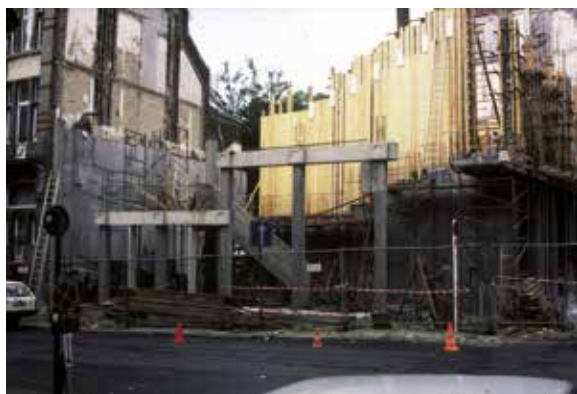
Fig. 12 Les colonnes du rez-de-chaussée de la façade à rue en construction, 1988-1989 (© AUCL, Faculté LOCI/Fonds Jean Cosse).
