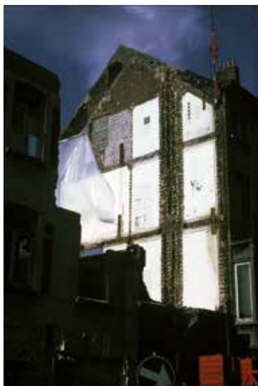
Fig. 2 Préparation du mur mitoyen côté rue Maurice Wilmotte pour l'épinglage au fur et à mesure de la démolition, 1988 (© AUCL, Faculté LOCI/Fonds Jean Cosse).
