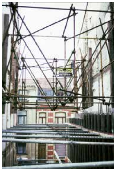
Fig. 3 Étañonnement du mur mitoyen côté rue d'Irlande, 1988 (© AUCL, Faculté LOCI/Fonds Jean Cosse).
