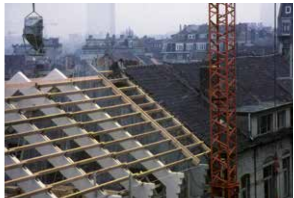
Fig. 20 Mise en place des pannes, 1989 (© AUCL, Faculté LOCI/Fonds Jean Cosse).
