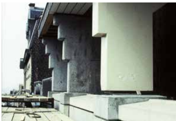
Fig. 21 Détail des appuis de la charpente et de la corniche, 1989 (© AUCL, Faculté LOCI/Fonds Jean Cosse).
