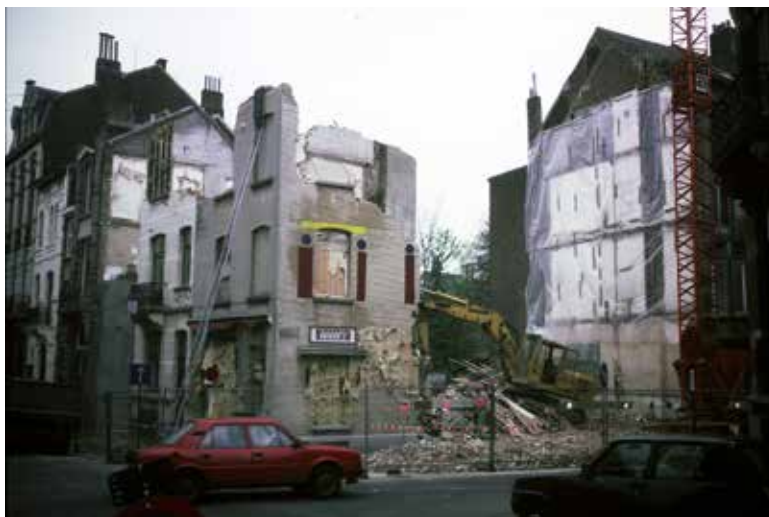
Fig. 6 Démolition des bâtiments d'angle, 1988 (© AUCL, Faculté LOCI/Fonds Jean Cosse).
