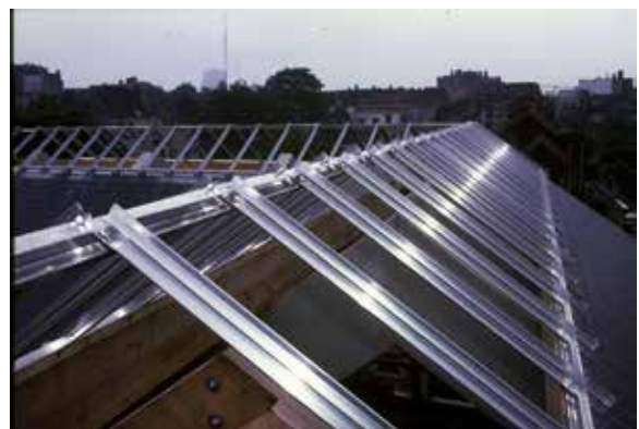
Fig. 22 La structure en aluminium pour le lanterneau faitier, 1989 (© AUCL, Faculté LOCI/Fonds Jean Cosse).
