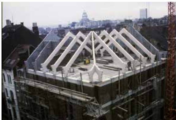
Fig. 19 Mise en place de toutes les charpentes, vue panoramique, 1989 (© AUCL, Faculté LOCI/Fonds Jean Cosse).
