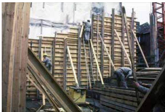
Fig. 14 Coffrages du voile en béton contre le mur mitoyen côté rue d'Irlande, 1989 (© AUCL, Faculté LOCI/Fonds Jean Cosse).
