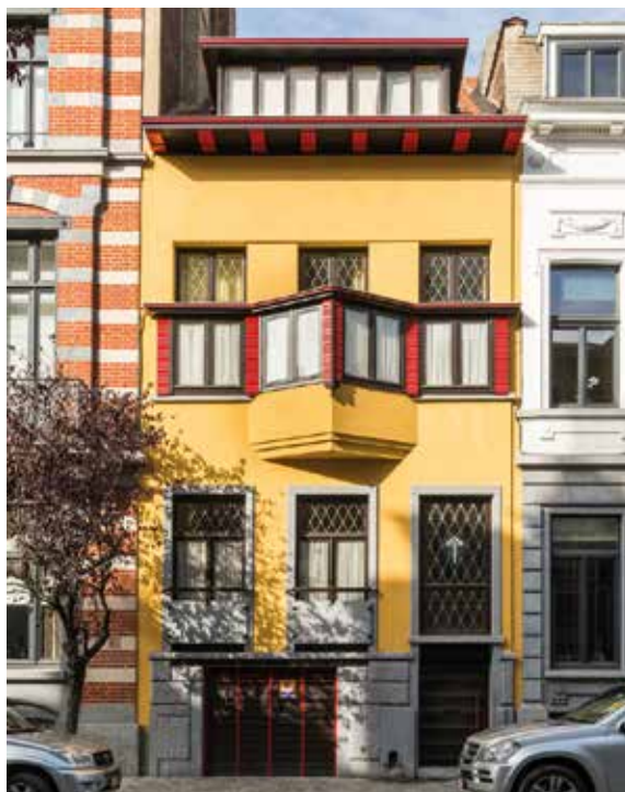
Fig. 8 Façade de la maison après restauration en 2013 par l'Atelier d'Architecture du Congrès (photo Vincent Everarts © Architecte Atelier d'architecture du Congrès – Frederic Hossey).
