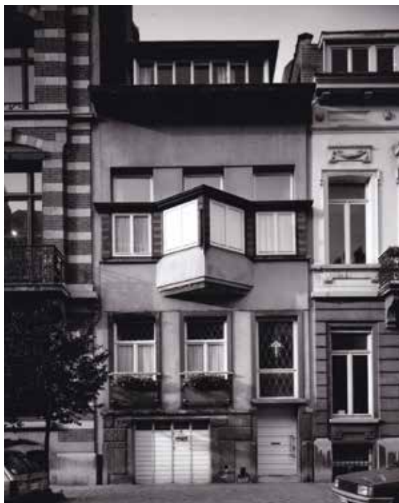
Fig. 7 Façade de la maison avant restauration (photo F. Loze, 1994).
