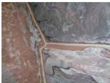
Fig. 7b Détail : application directe de joints plus fins en mortier beige (technique du mouillé sur mouillé) (© AVAPartners).
