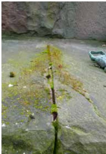
Fig. 2a Jointolement côté supérieur du socle avant les travaux de restauration (© AVAPartners).
