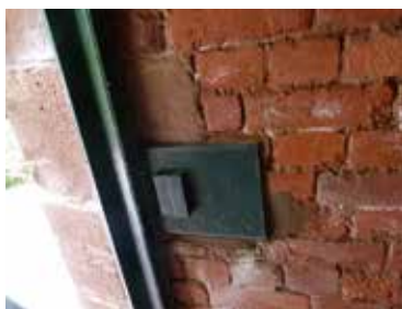
Fig. 8b Plaque de verrouillage définitive de la grille, juste avant sa finition (© AVAPartners).
