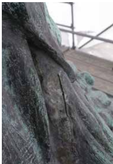
Fig. 3 Fissure béante entraînant des infiltrations d'humidité (© Metafose).
