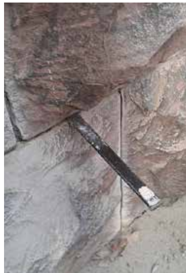
Fig. 6 Refouillement circonspect des joints, sans meulage (© AVAPartners).
