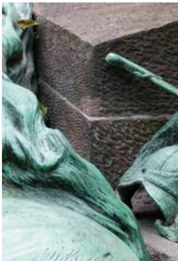
Fig. 5b Réparation du sarcophage après finition avec taille à l'identique (© AVAPartners).
