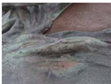
Fig. 9a Fissure avant traitement (© Metafosel).
