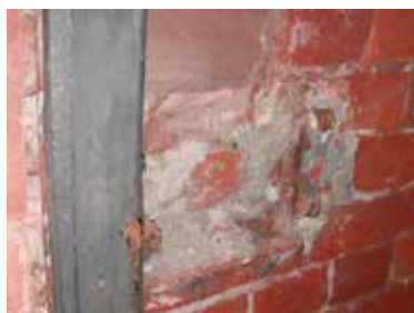
Fig. 8a Plaque de verrouillage disparue de la grille (© AVAPartners).
