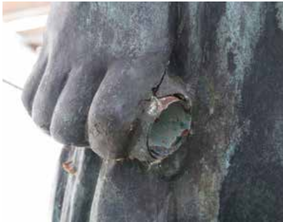
Fig. 11a Ancienne réparation à hauteur de la main, après enlèvement du trident (© Metafose).
