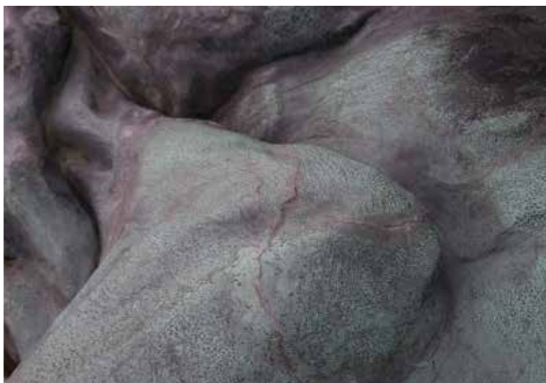
Fig. 4 Anciennes réparations à la résine de polyester qui se fissurent à nouveau (© Metafose)
