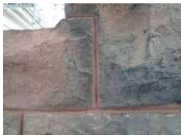
Fig. 7a Grands joints récemment appliqués au mortier rouge et rainures plus fines ménagées dans ceux-ci (© AVAPartners).
