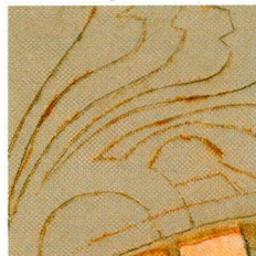
Exécution du tracé dans l'enduit frais, rue Herkoliers 35, Koekelberg
