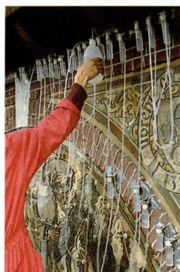
Consolidation de la couche de fond par injections rue Moreau 170, Anderlecht
