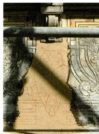
Dessin des contours sur l'enduit
