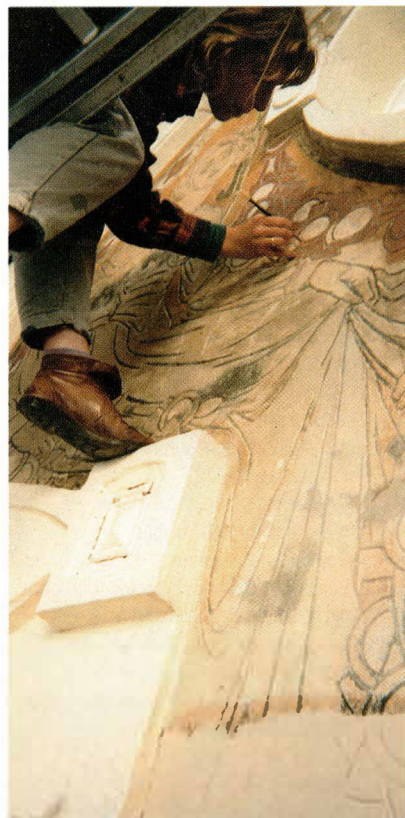
Restitution au mortier de chaux des parties cimentées avenue de la Chasse 141, Etterbeek
